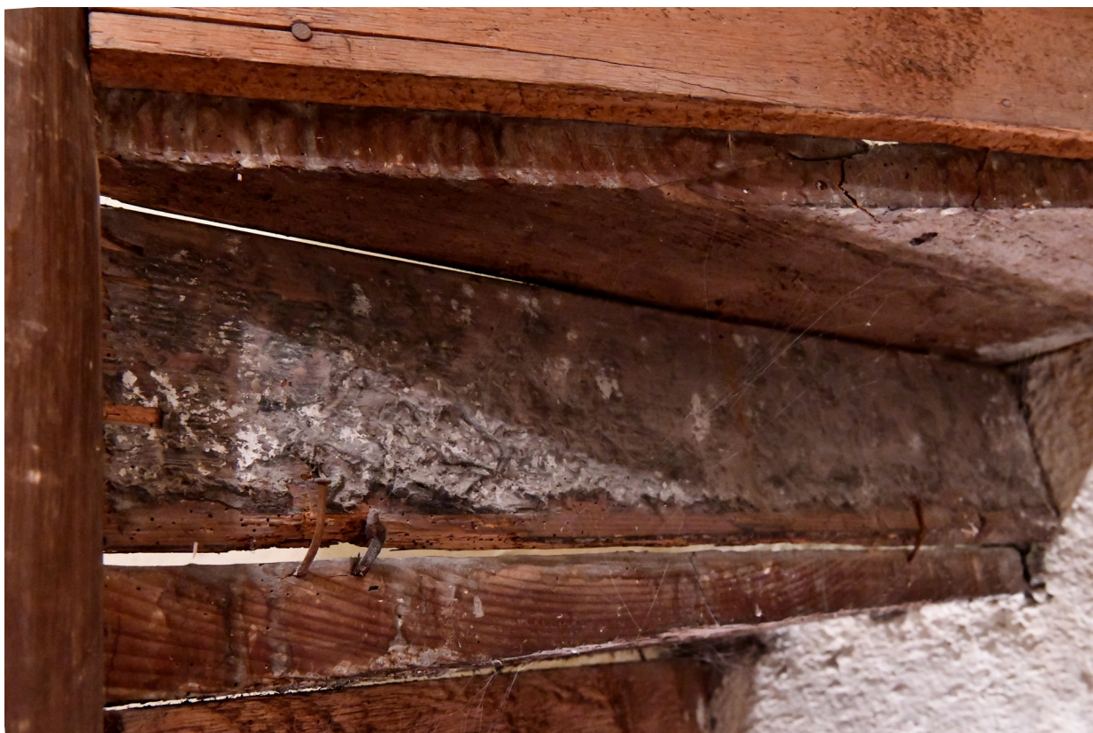
Spodní podstupnice opět pouze vložena a jen letmo přichycena hřeby. Horní podstupnice také nadrží díky vyštípnutí a nedostatečnému přesazení.
