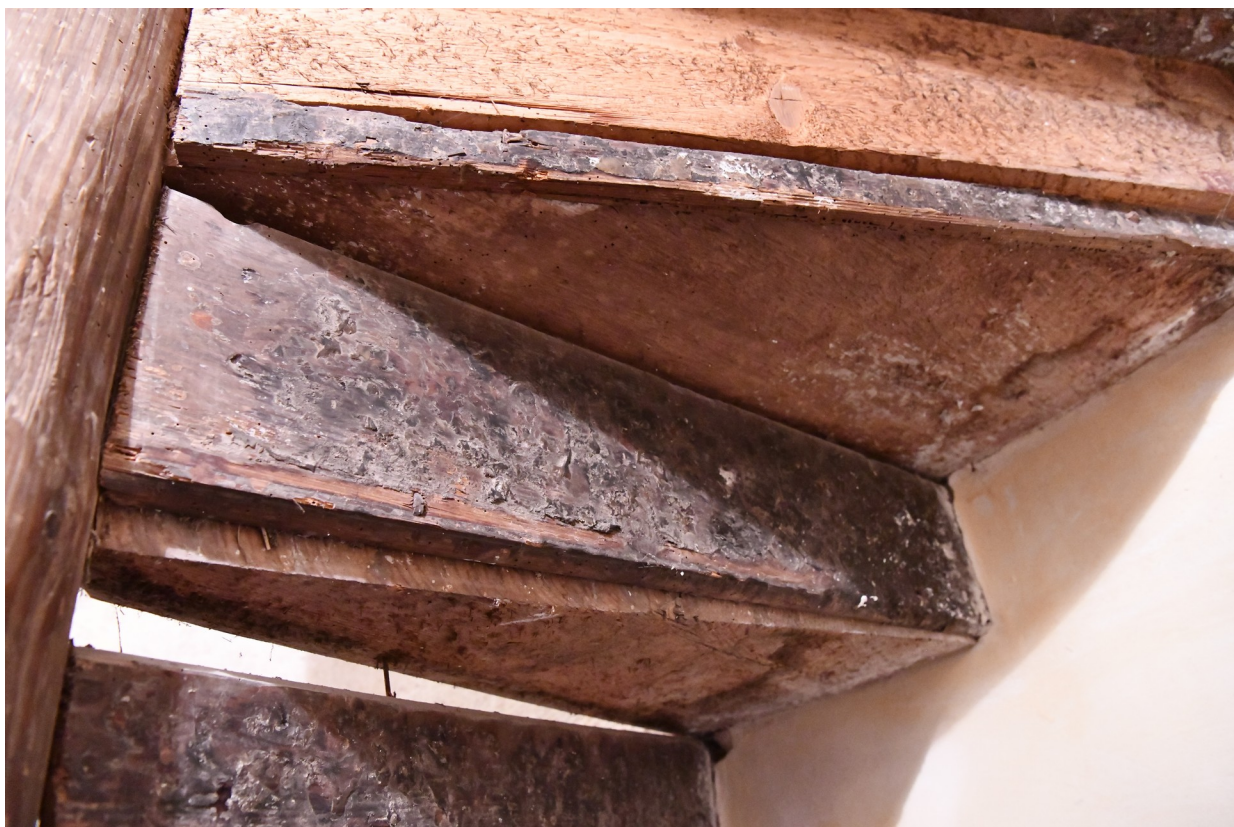
Některé podstupnice jsou uvolněné. Zde spodní. Jiné podstupnice jsou vložené. Horní.
