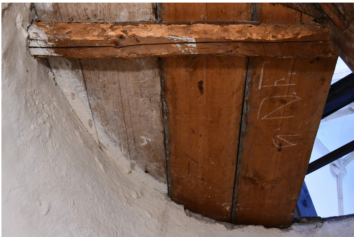
Záklop schodiště má již měněná prkna. Neodkorněný trámeček byl napaden tesaříkem.
