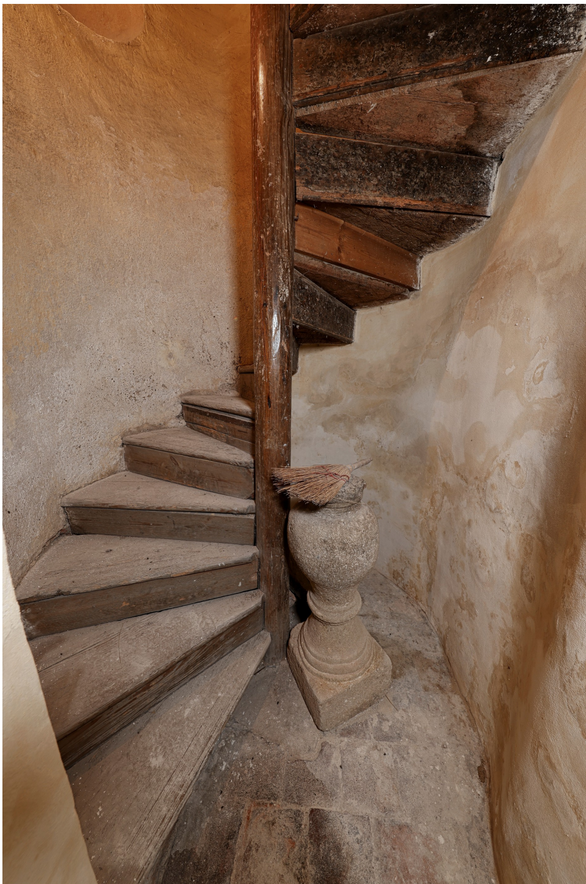
Pohled na schodiště z lodi kostela. Z podhledu jsou patrné doplňované části. Nášlapné hrany jsou opotřebovány a některé je nutno protézovat. Zde 3. a 7. stupeň.
