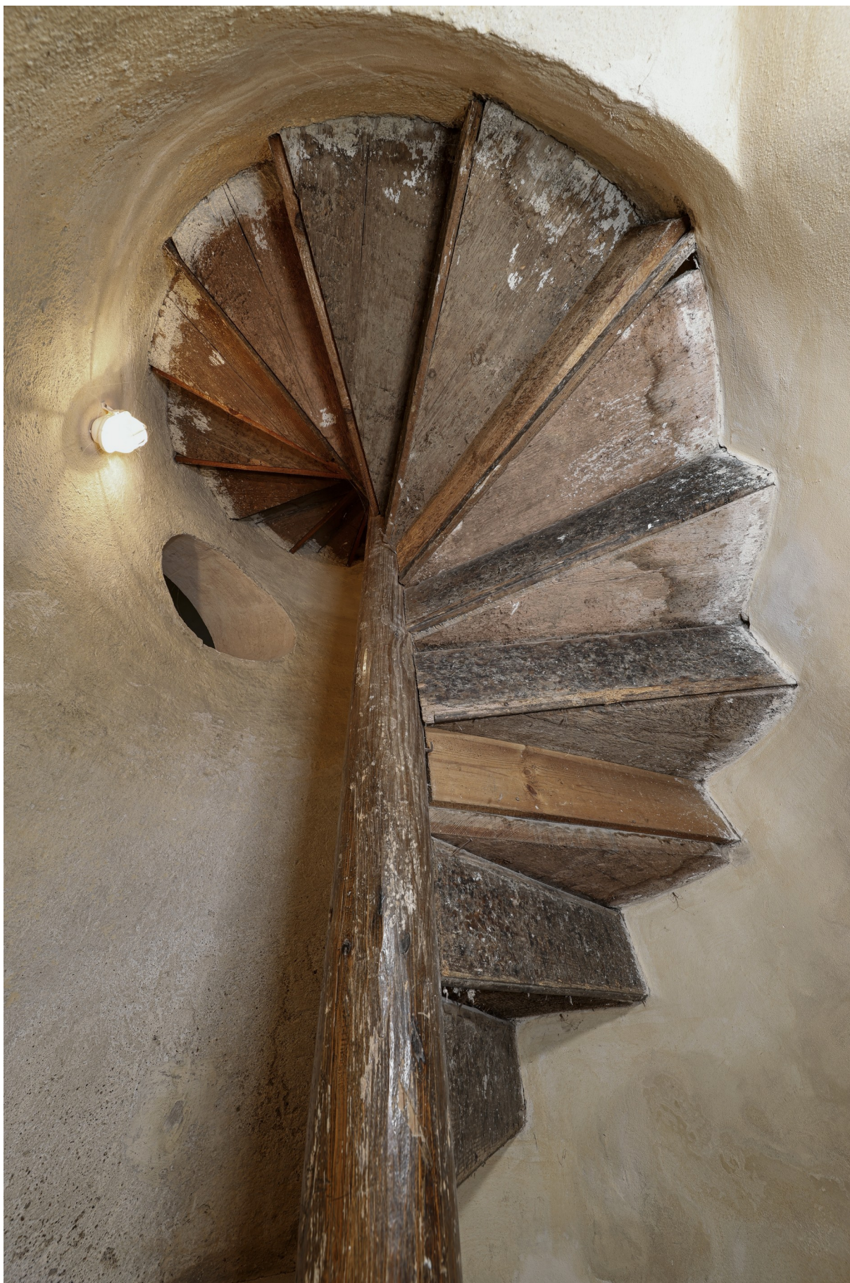
Některé stupně bude nutno scelit špánováním a doplnit. Zde v úrovni okna. Mnohé podstupnice je nutno nastavit. Například tu přichycenou skobou.
