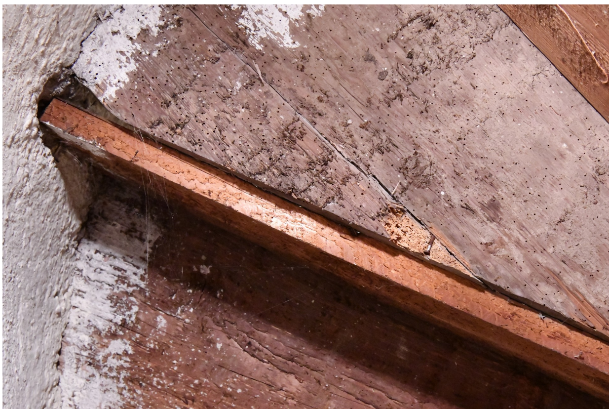
Zde podstupnice přibita jen napůl. Snaha po přibití prasklého stupně způsobila odlomení červotočem značně poškozeného masivu.
