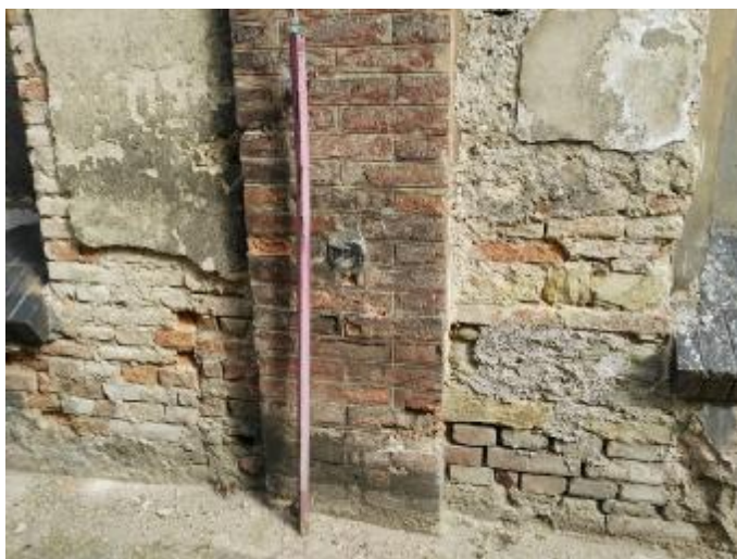
Degradace omítek vlhkostí a mrazem
