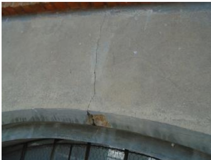
Trhliny v nadokenním klenutém překladu
