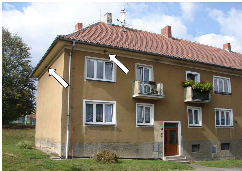
Obr. 11 Jižní a východní stěna domu č.p. 259 s hnízdy jiříček obecných pod střešní římsou.
