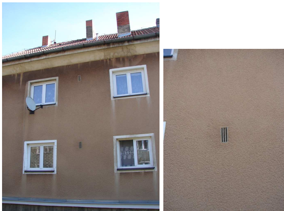
Obr. 38 Detail větracích otvorů na severní stěně domu č.p. 231 -236.
