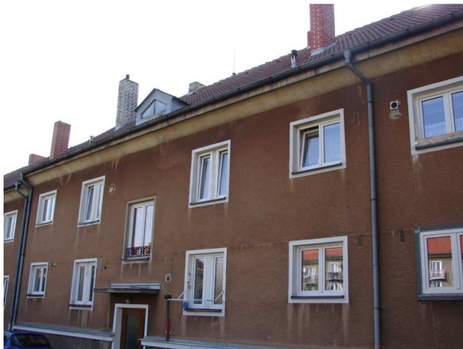
Obr. 37 Severní strana domu č.p. 231 – 236
