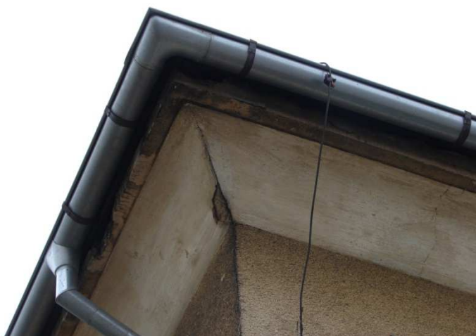
Obr. 29 Pohled na vletové otvory patrné v okraji římsy zvnějšku na SV rohu budovy.
