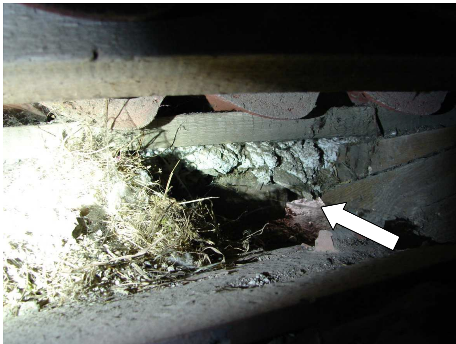
Obr. 60 Místo hnízdění rorýsů obecných na západní straně budovy nad č.p. 207. Šipka označuje přístupový otvor do podstřeší.
