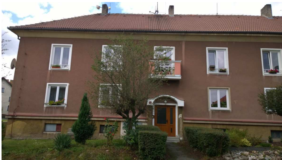
Obr. 80 Východní strana budovy č.p. 240 -241.
