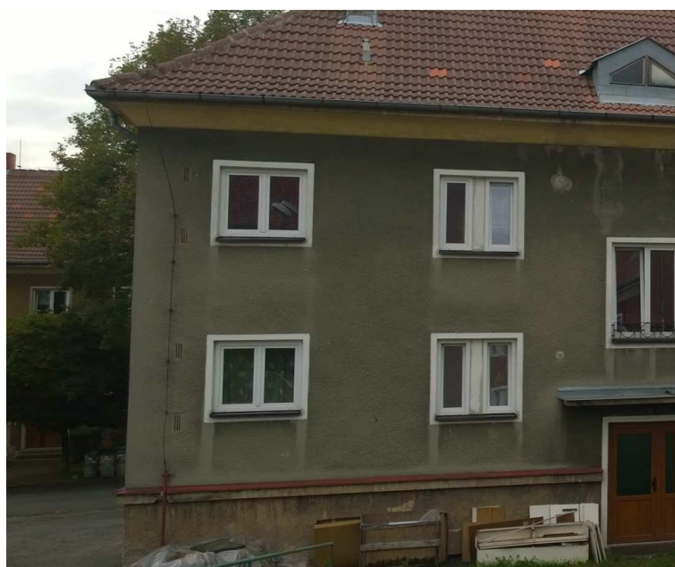
Obr. 89 Větrací otvory na severní straně domu.
