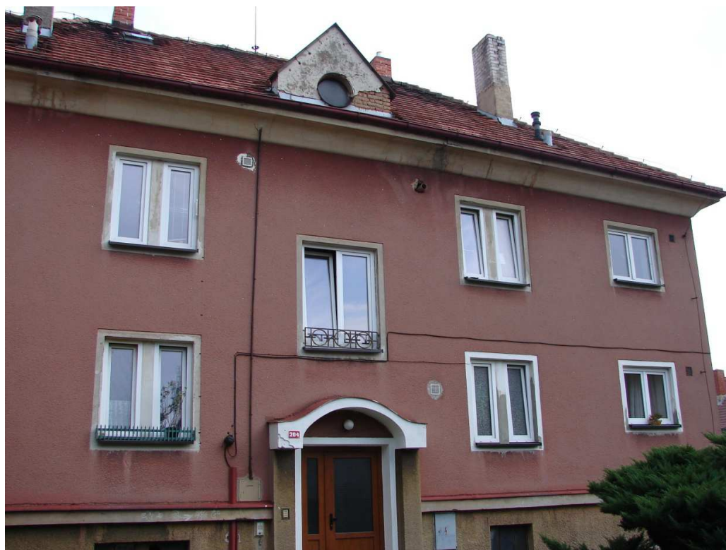
Obr. 52 Západní stěna budovy s větracími otvory překrytými neprostupnou mřížkou.
