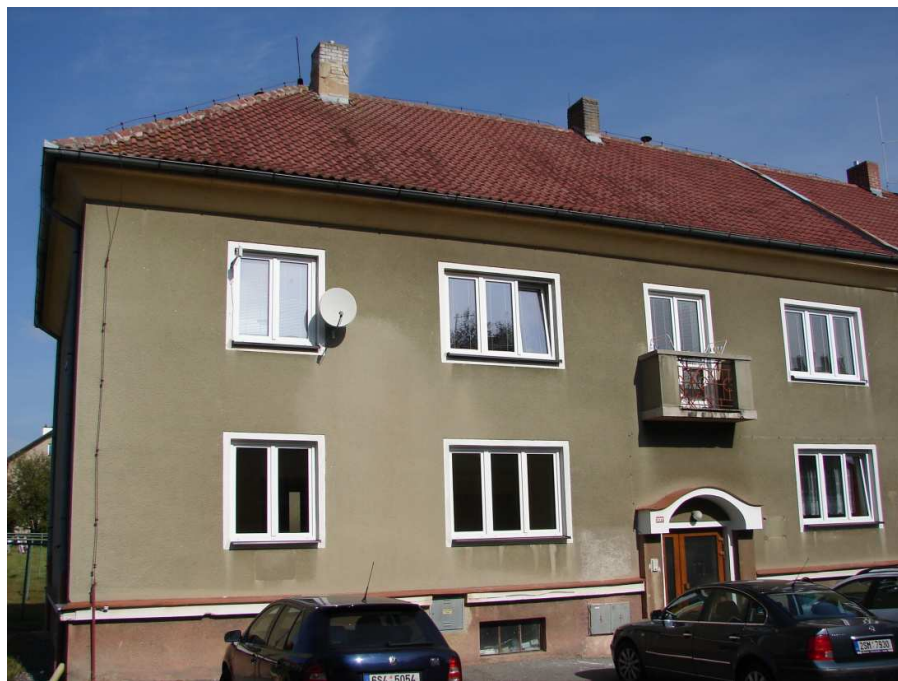
Obr. 44 Jižní stěna domu č.p. 237 - 239.
