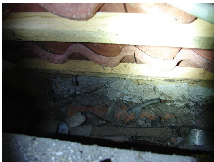
Obr. 15 Většina střechy má maltou zaslepenou šterbinu mezi střechou a okrajem římsy.
