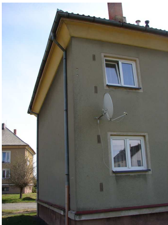
Obr. 46 Severozápadní roh domu č.p. 239 s větracími otvory.
