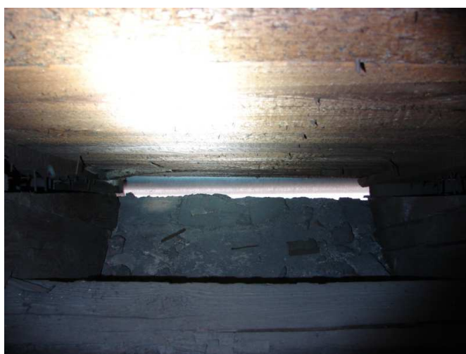
Obr. 28 Štěrbina mezi okrajem střechy a obvodovou zdí – vletový otvor pro rorýse a netopýry.
