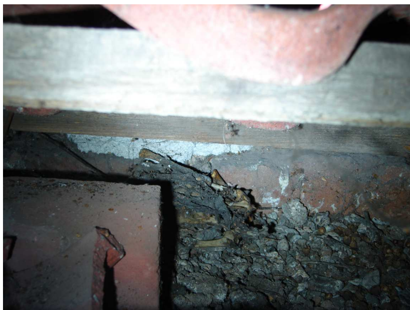
Obr. 61 Trus a kostry holubů v podstřeší na jižní straně budovy č.p. 207.
