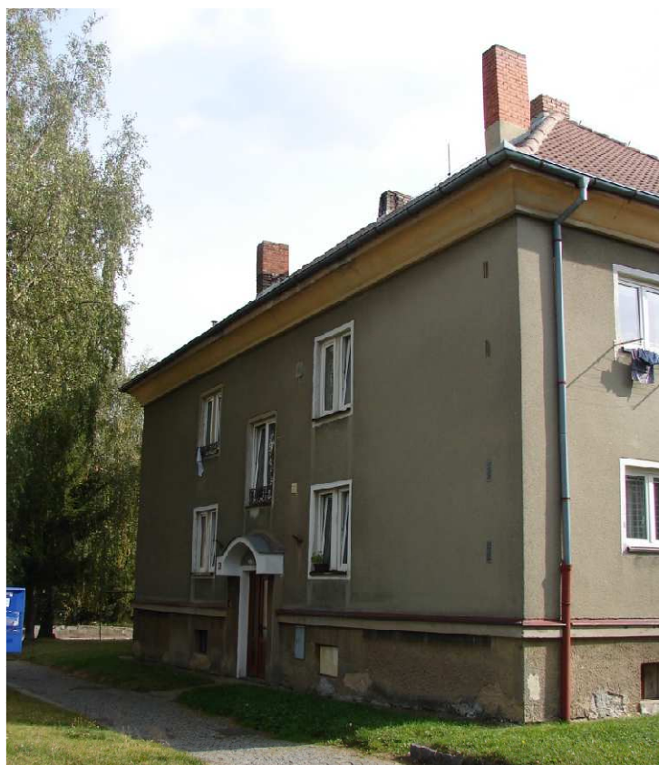
Obr. 59 Severní strana domu u č.p. 205, viditelné větrací otvory (dva spodní uzavřené).
