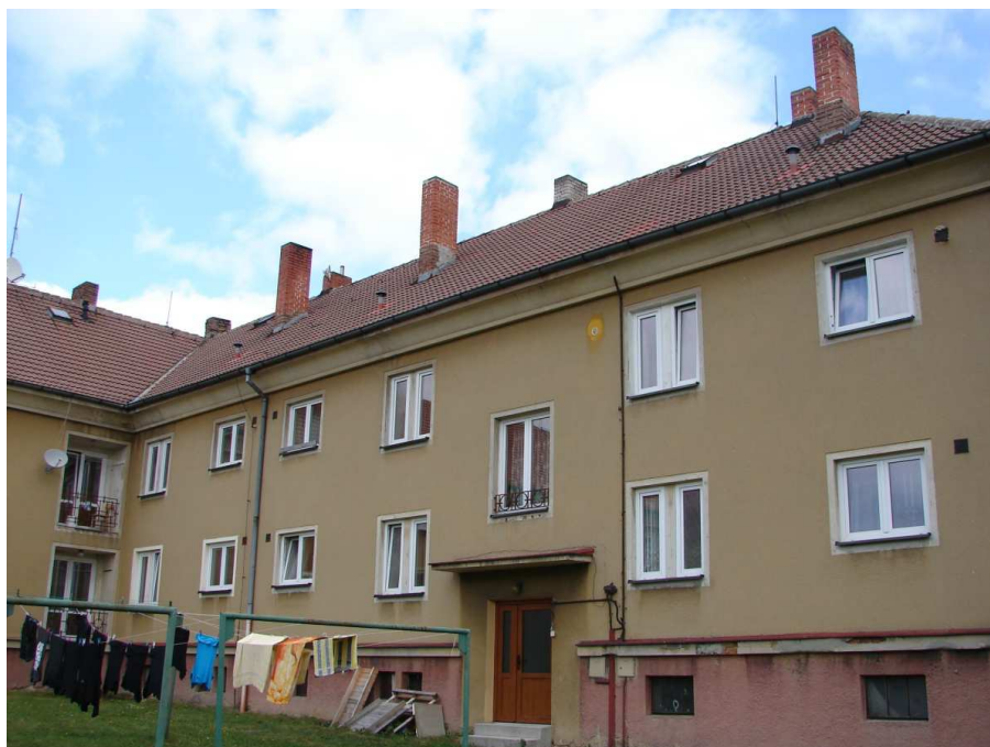
Obr. 63 Západní strana domu čp. 213 a 214. Větrací otvory uzavřené neporušenými mřížkami.
