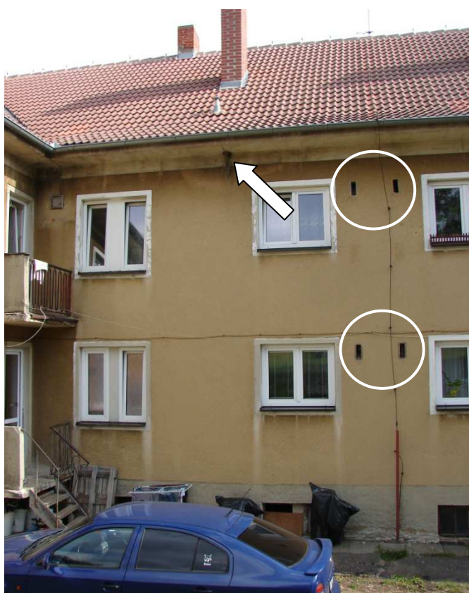
Obr. 13. Západní strana domu s hnízdem jiříček obecných pod střešní římsou (šipka) a hnízdy drobných pěvců ve větracích otvorech, ze kterých chybí mřížky (označeno kroužky). Vpravo detail větracího otvoru bez mřížky, ze kterého vyčnívá hnízdní materiál.
