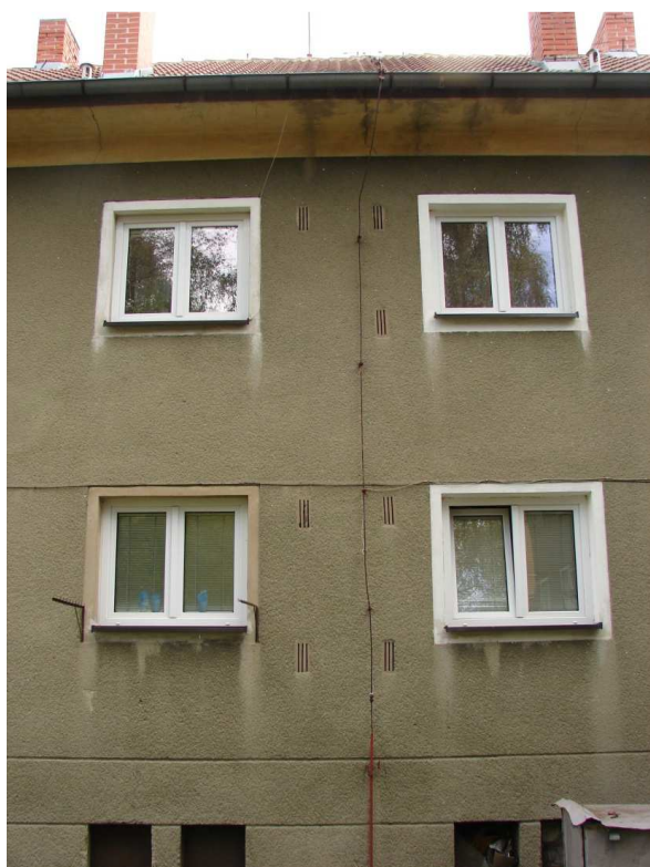
Obr. 9 Detail části větracích otvorů na západní straně domu, za kterými se nachází potenciální úkryty netopýrů.
