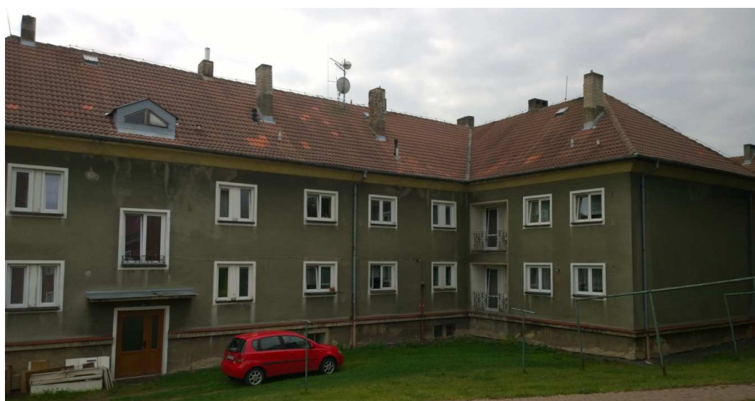
Obr. 88 Pohled na severní stranu domu č.p. 226 – 227.
