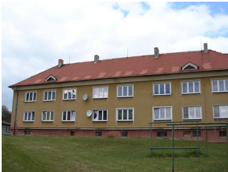
Obr. 62 Jižní strana domu č.p. 211 a 212.
