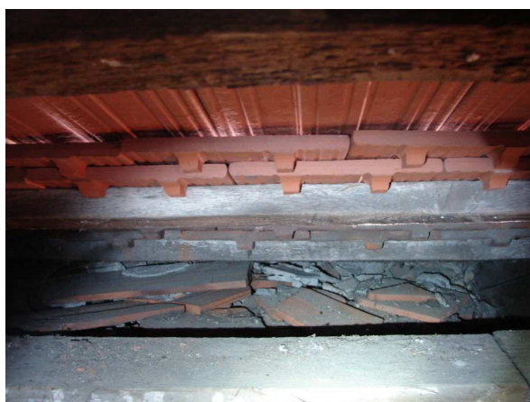
Obr. 64 Část střechy se zaslepeným vstupem do prostoru za pozednicí a staré hnízdo vrabců.
