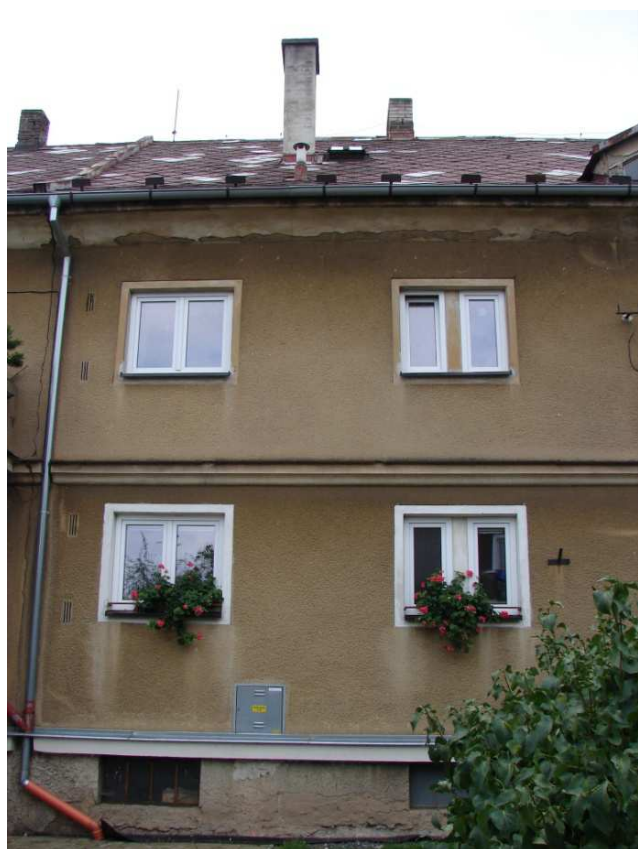
Obr. 26 Severní stěna domu s větracími otvory.
