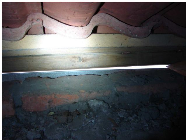
Obr. 17 Přístupová šterbina podél západní strany budovy u č.p. 260.
