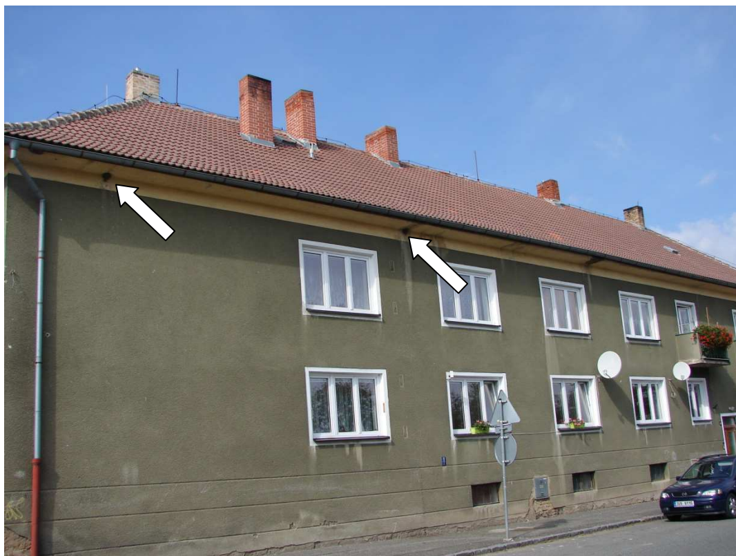
Obr. 8 Hnízda jiříček obecných pod římsou na východní straně domu č.p. 257.
