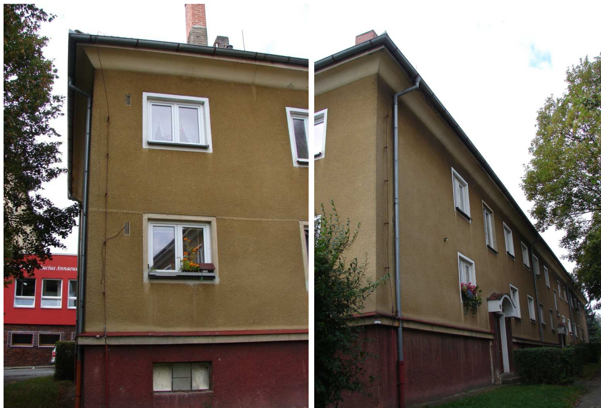
Obr. 74 Větrací otvory na východní stěně domu č.p. 230 – potenciální úkryty menších druhů netopýrů (a). SV roh domu č.p. 228 – 230, za nímž bylo nalezeno hnízdo rorýsů (b).
