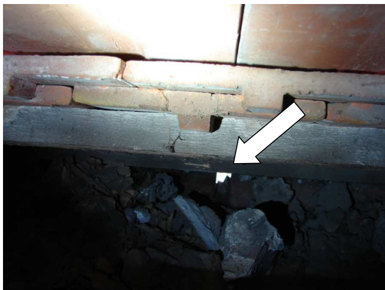
Obr. 66 Místo hnízdění rorýsů v podstřeší na jižní straně domu č.p. 211. Šipka ukazuje vstupní otvor.
