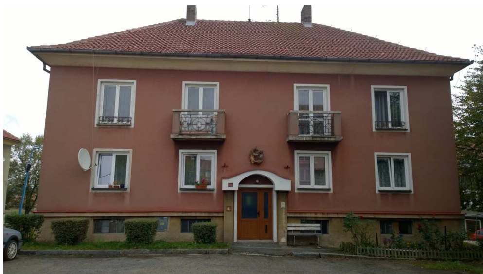
Obr. 86 Celkový pohled na vchodovou stranu budovy č.p. 225.
