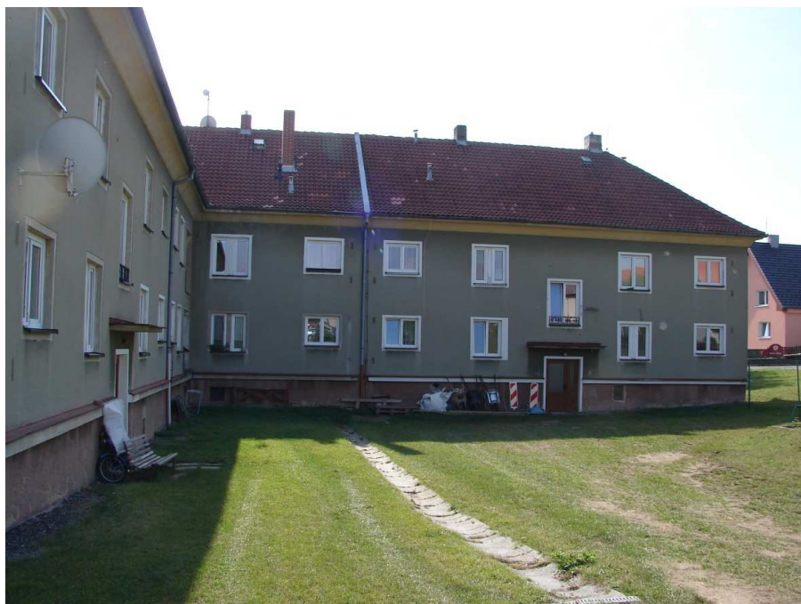
Obr. 45 Severní strana domu 237 a západní strana domu 239.
