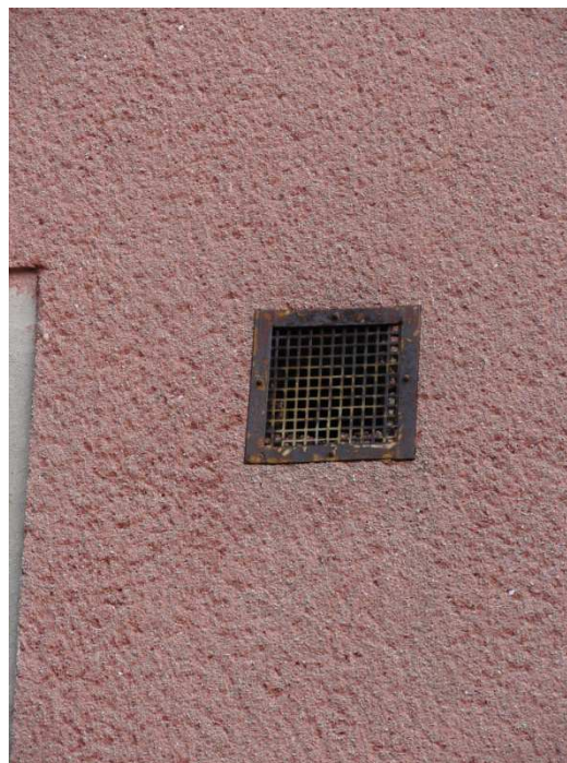
Obr. 53 Západní stěna budovy s větracími otvory a detail neprostupné mřížky.
