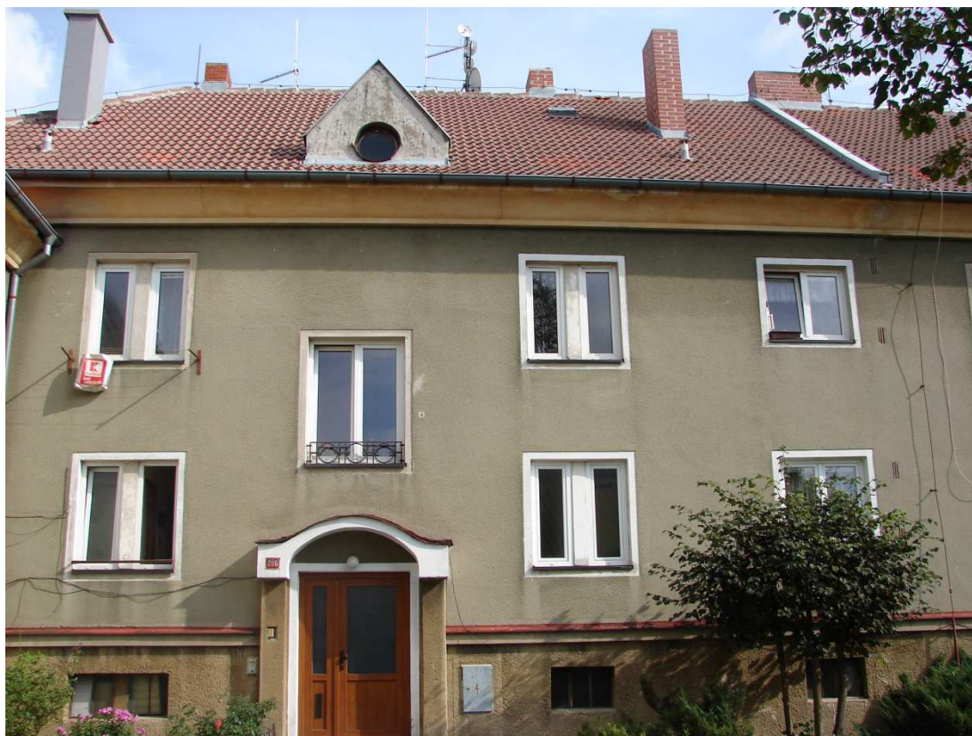
Obr. 58 Západi stěna části domu u č.p. 206 (v pravé části patrné větrací otvory).
