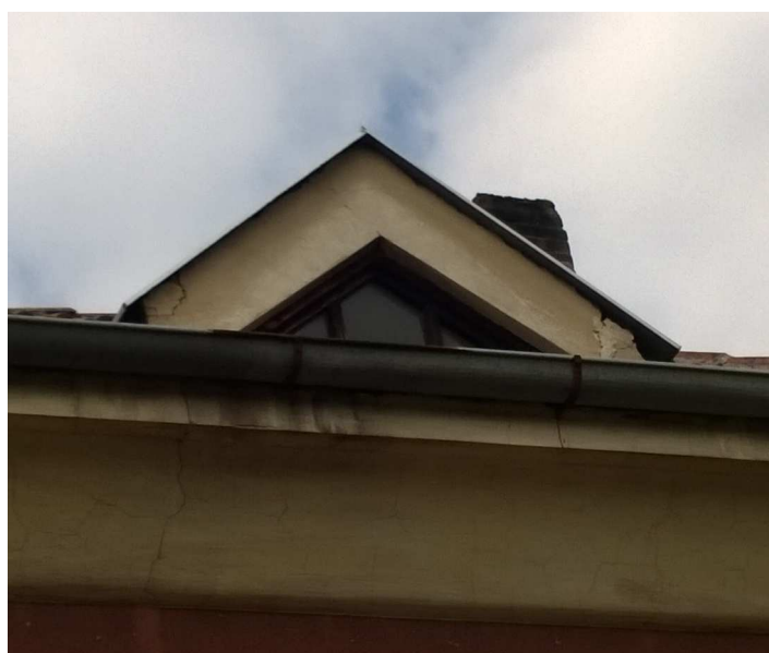
Obr. 87 Oplechování vikýře s velkými prasklinami ve zdivu, které mohou sloužit jako potenciální přístupové otvory pro štěrbinové druhy netopýrů.
