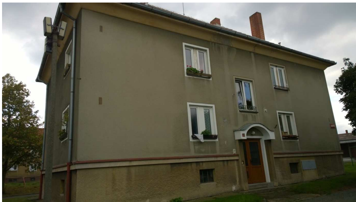
Obr. 83 Východní strana domu č.p. 208– větrací otvory.
