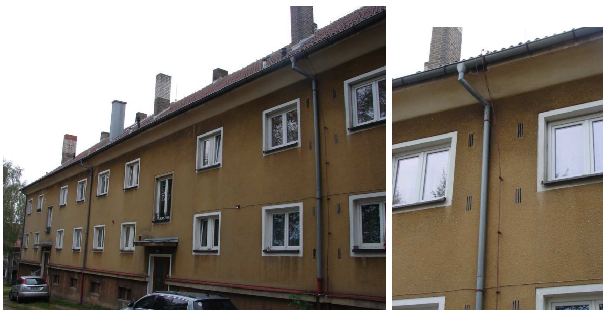
Obr. 91 Severní stěna domu se štěrbinovými větracími otvory a detail charakteru otvorů.
