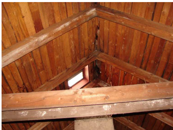
Obr. 27 Pohled zevnitř z půdy na dřevěné podbití střechy domu č.p. 244 – 246.
