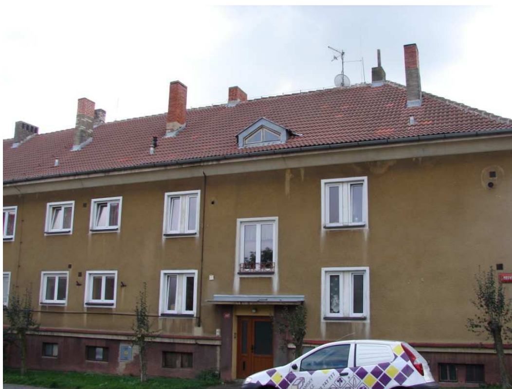
Obr. 68 Severní strana domu s uzavřenými větracími otvory (2. část).
