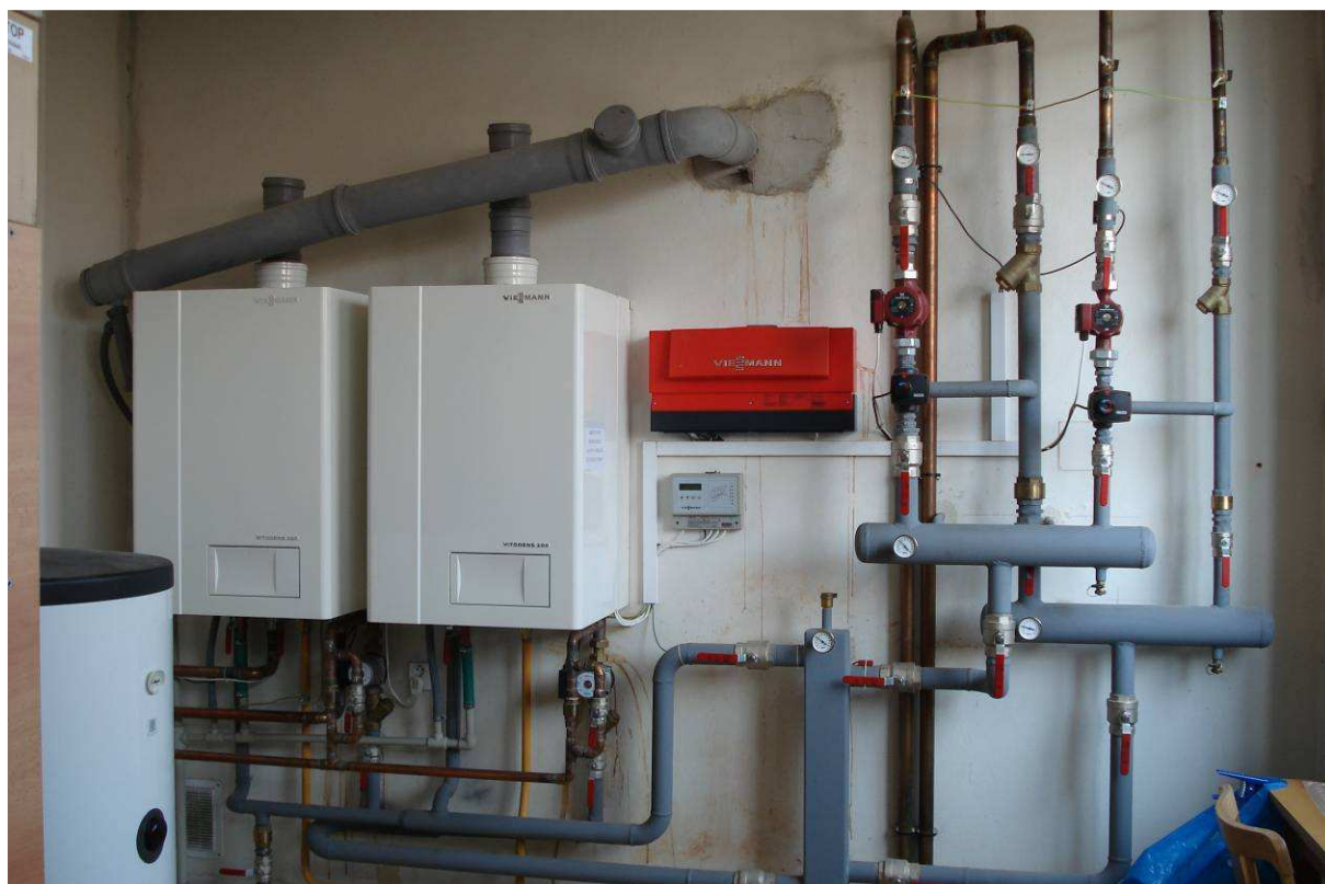
Obrázek č.6 – Plynové kotle Vitodens 200 ve 2.NP
