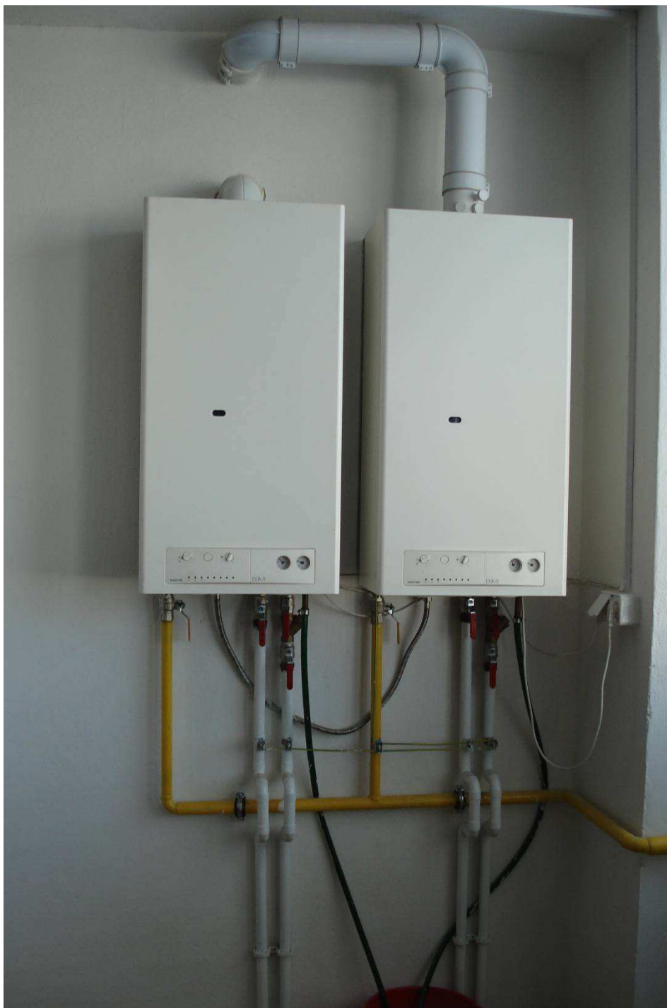
Obrázek č.4 – Plynové kotle DAKON DUO 24 ve 3.NP
