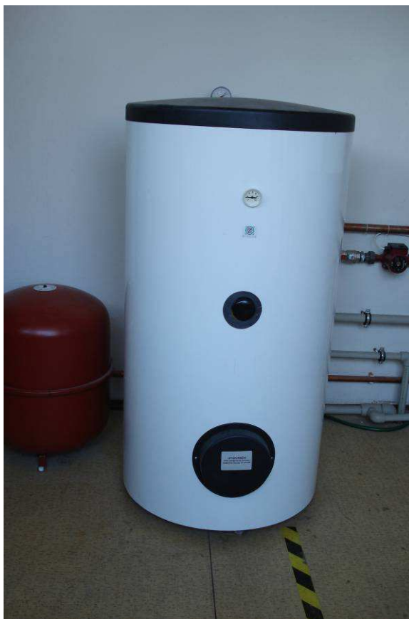
Obrázek č.5 – Výměník TUV
