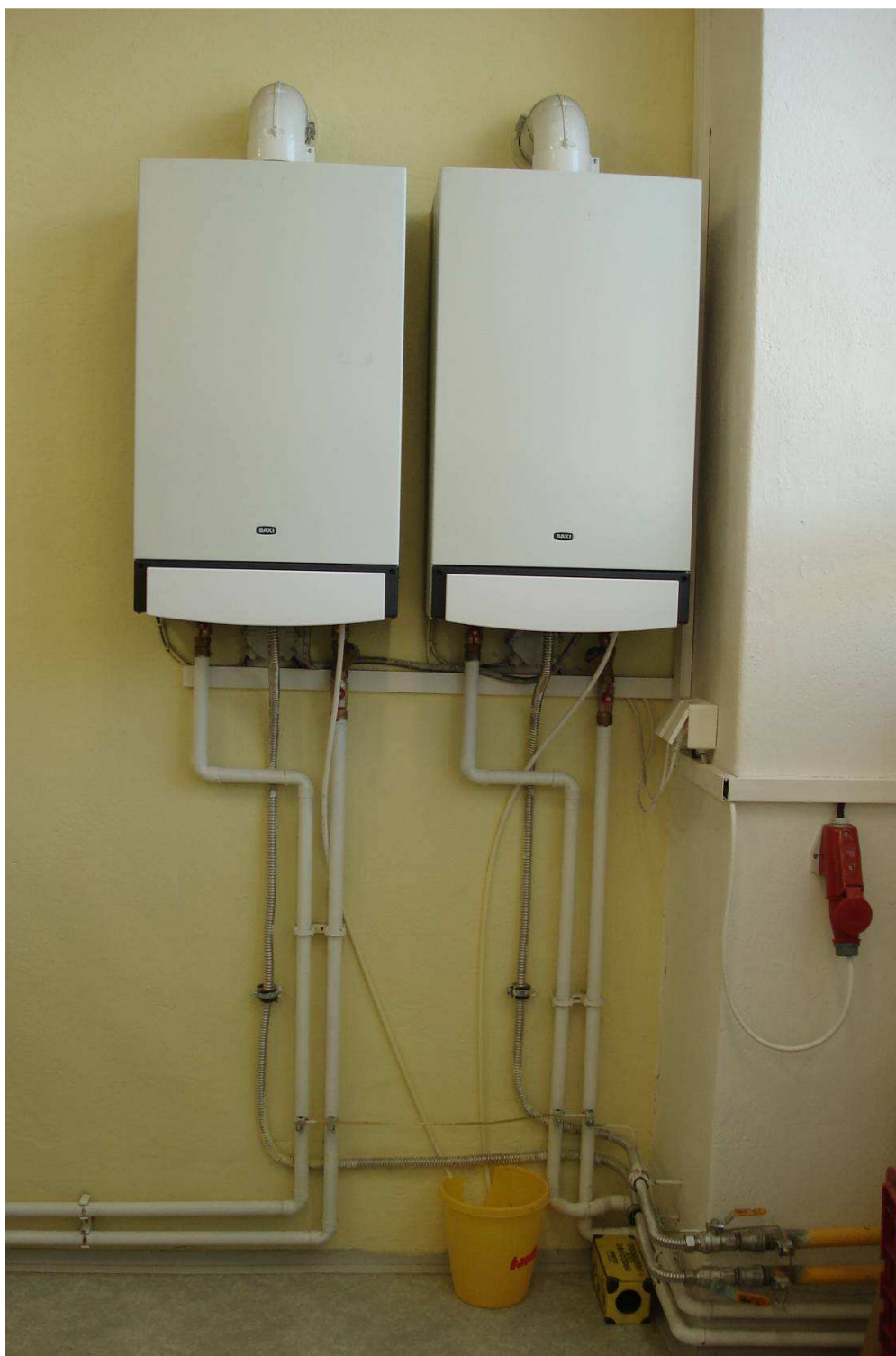
Obrázek č.7 – Plynové kotle BAXI LUNA 200 v 1.NP
