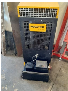
Tepl vzdušná olejová kamna – autoservis
