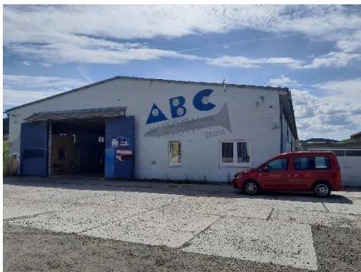
Severozápadní pohled – prodejní sklad
