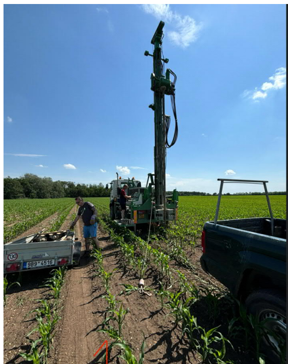
Fotodokumentace vrtných prací
