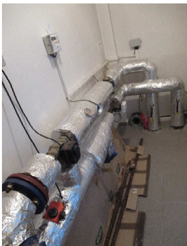
Přívod a fakturační měření tepla
