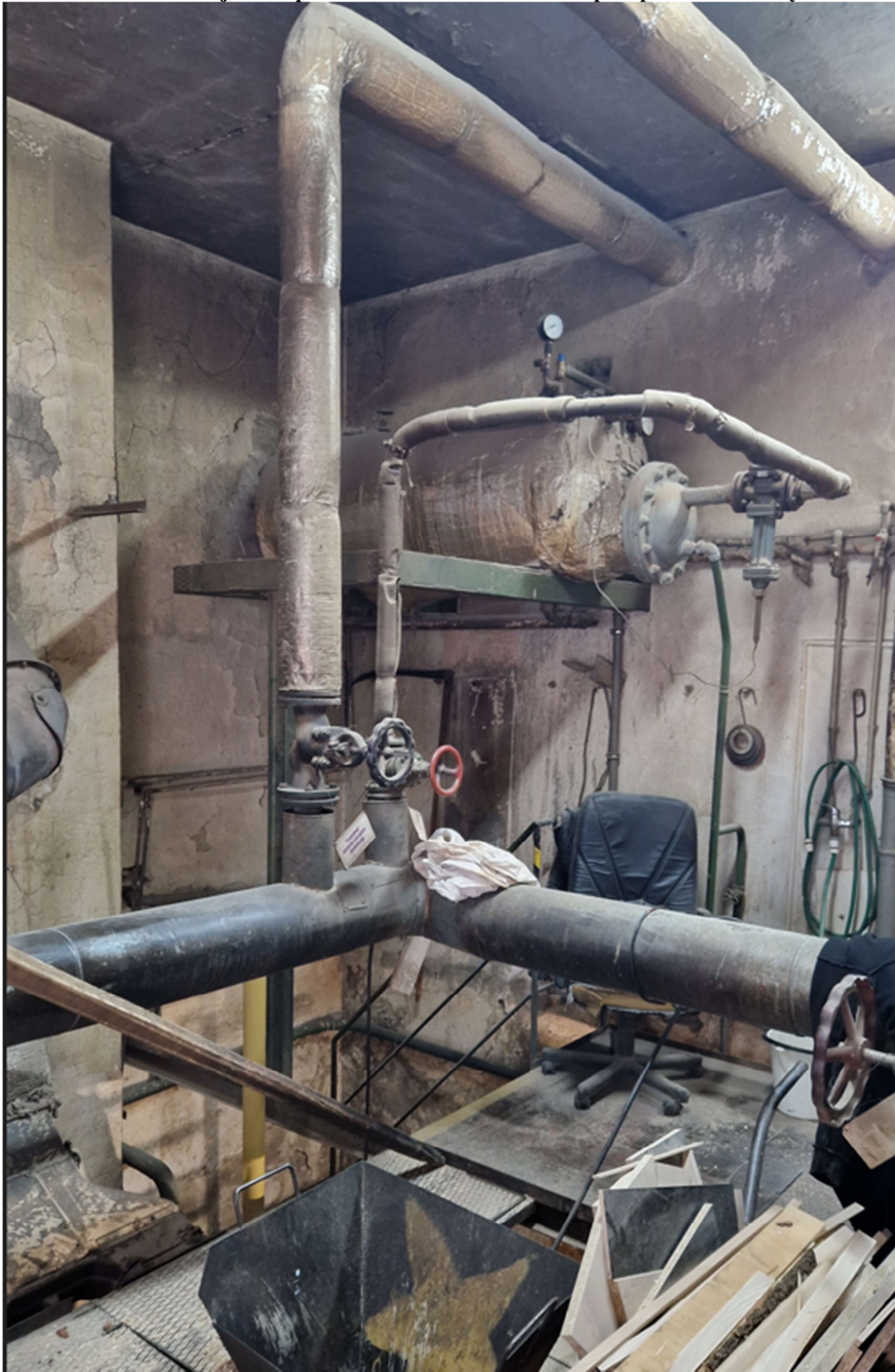
Fotodokumentace stávajícího teplovodního kotle ROUČKA 200 pro spalování biomasy
