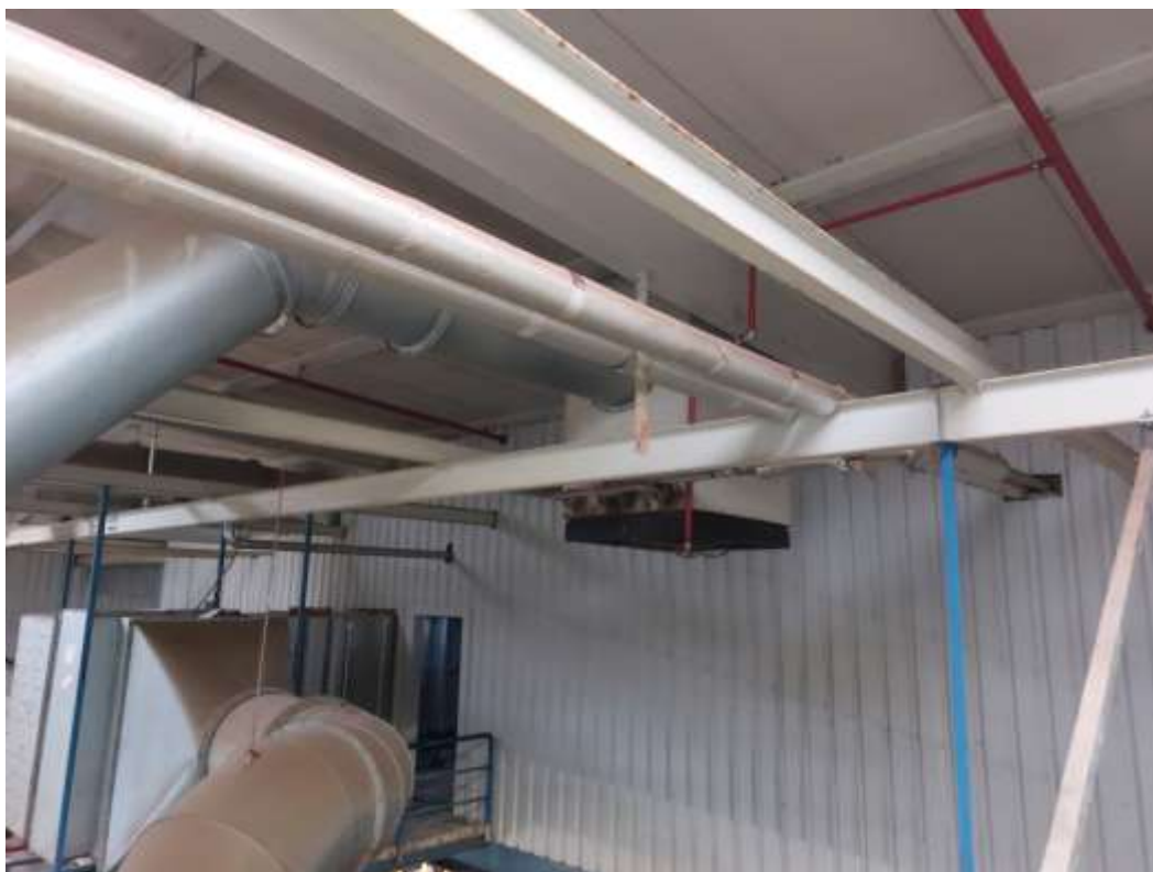
Obr. 6: Hala H06: Ocelový roznášecí rošt IPE160, zavěšený na ocelové rámy a podélný průvlek (nezatěžuje vaznice IPE160)
