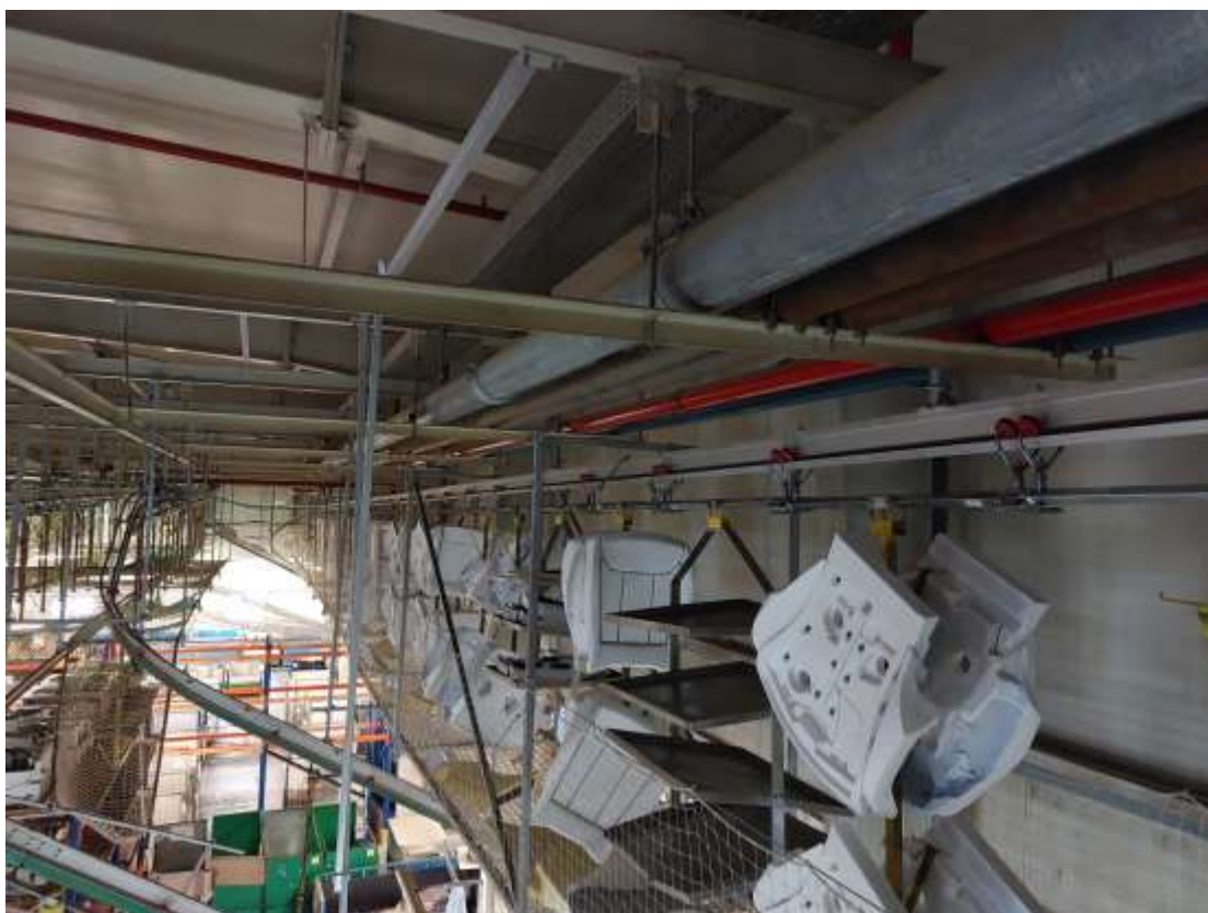
Obr. 6: Hala H06: Ocelový roznášecí rošt IPE160, zavěšený na ocelové rámy a podélný průvlek (nezatěžuje vaznice IPE160)
