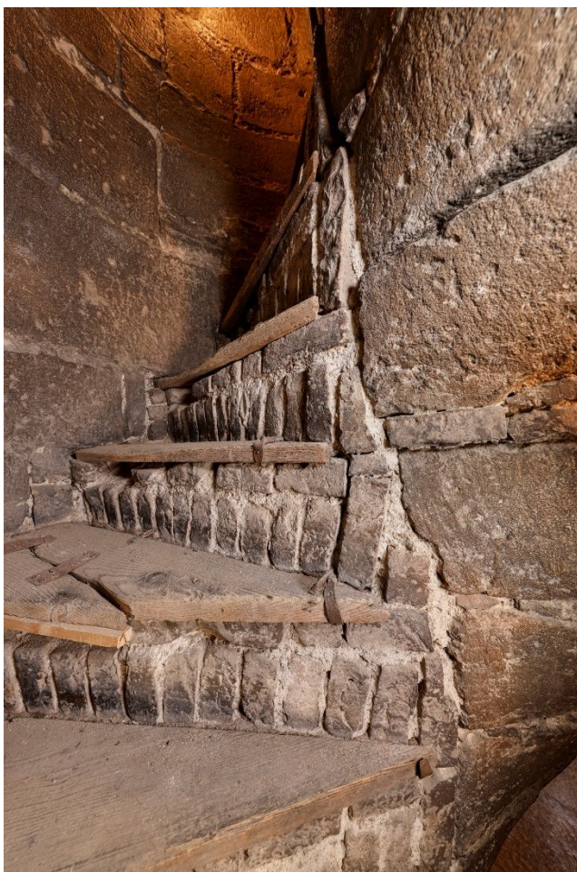
9. Detailní pohled na horní část JZ kamenného točitého schodiště podezděnou cihlami.
