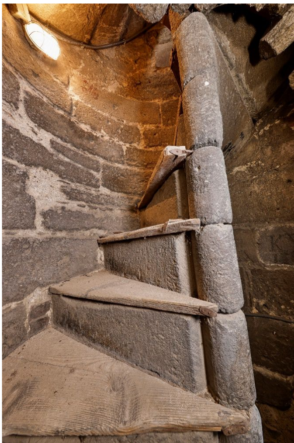
5. Detailní pohled na JZ kamenné točité schodiště ve spodní části za vstupem.
