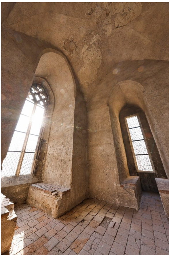
29. Západo a severní stěna síně ve 3. NP ve věži a poškozená podlaha z keramických půdovek (topinek).
