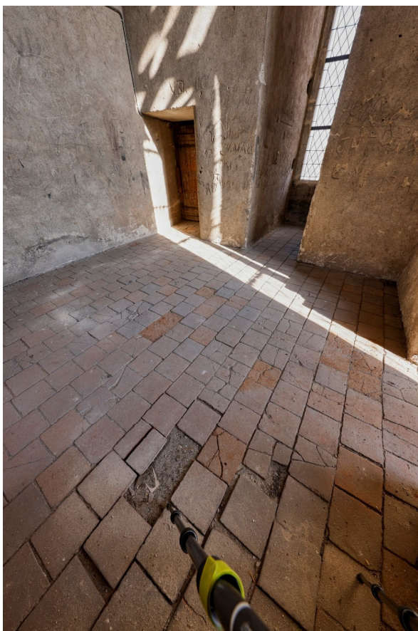
33. Detail poškozené dlažby z keramických půdovek (topinek) na podlaze síně ve 3. NP ve věži.
