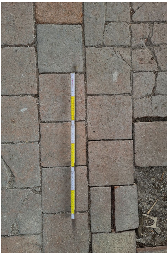
35. Detail poškozené dlažby z keramických půdovek (topínek) na podlaze síně ve 3. NP ve věži.
