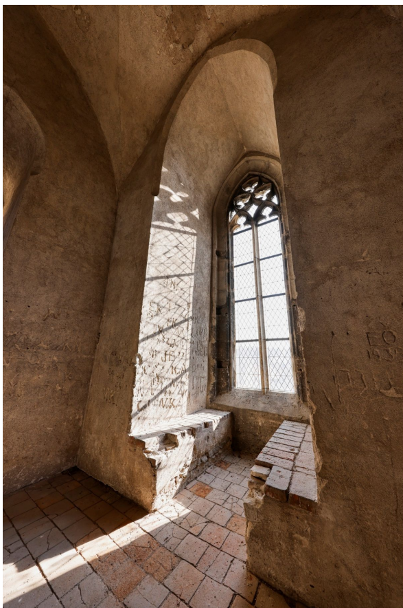
31. Pohled na poškozenou cihelnou dlažbu na zděné lavici (sedile) u okna západní stěně síně ve 3. NP ve věži.
