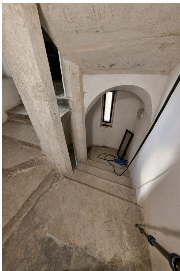
42. Kamenná dvojice pilířů a spodní partie restaurátorsky opravovaného prostoru SZ kamenného čtyřramenného schodiště.
