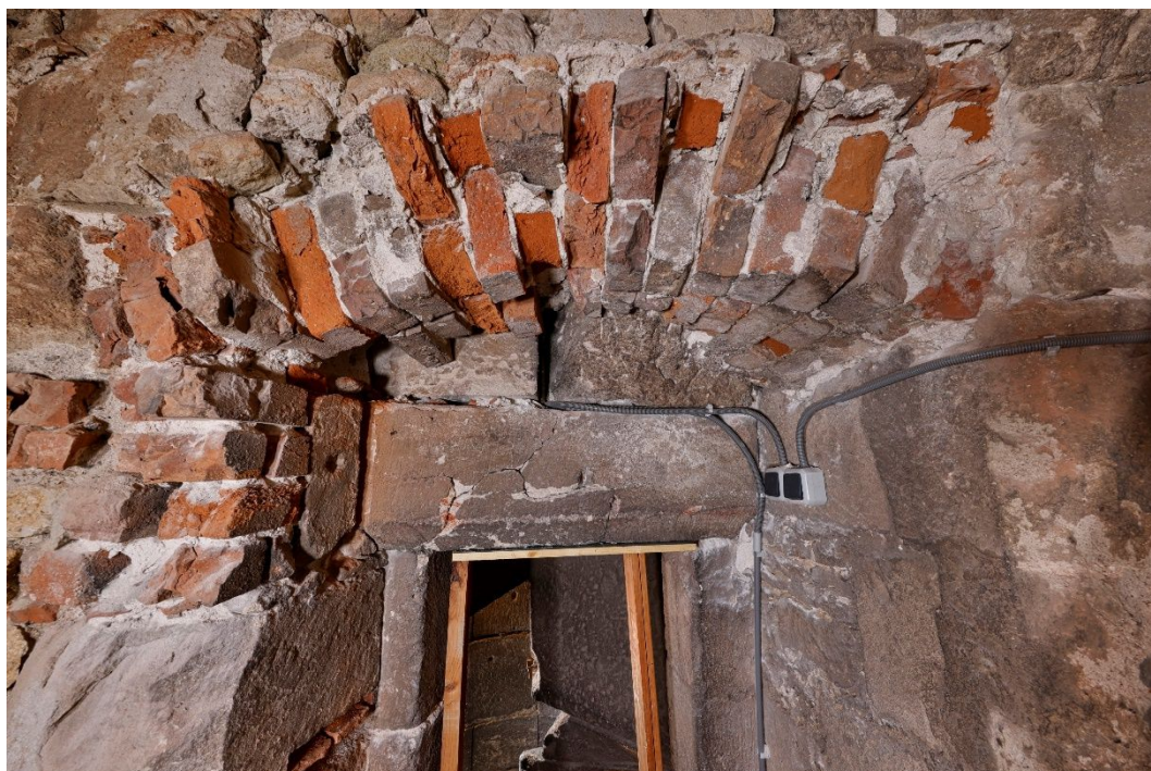
17. Detailní pohled na zlomený kamenný překlád v nadpraží vstupního otvoru na půdu.
