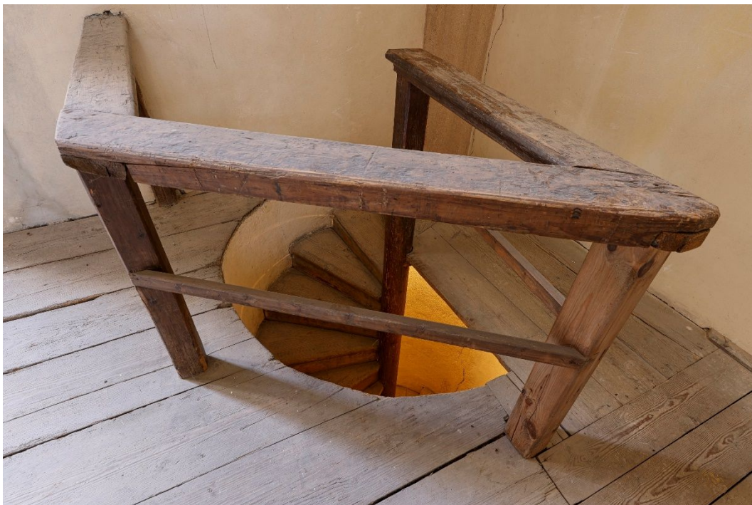
2. Výstupní část JZ dřevěného točitého schodiště se zábradlím.
