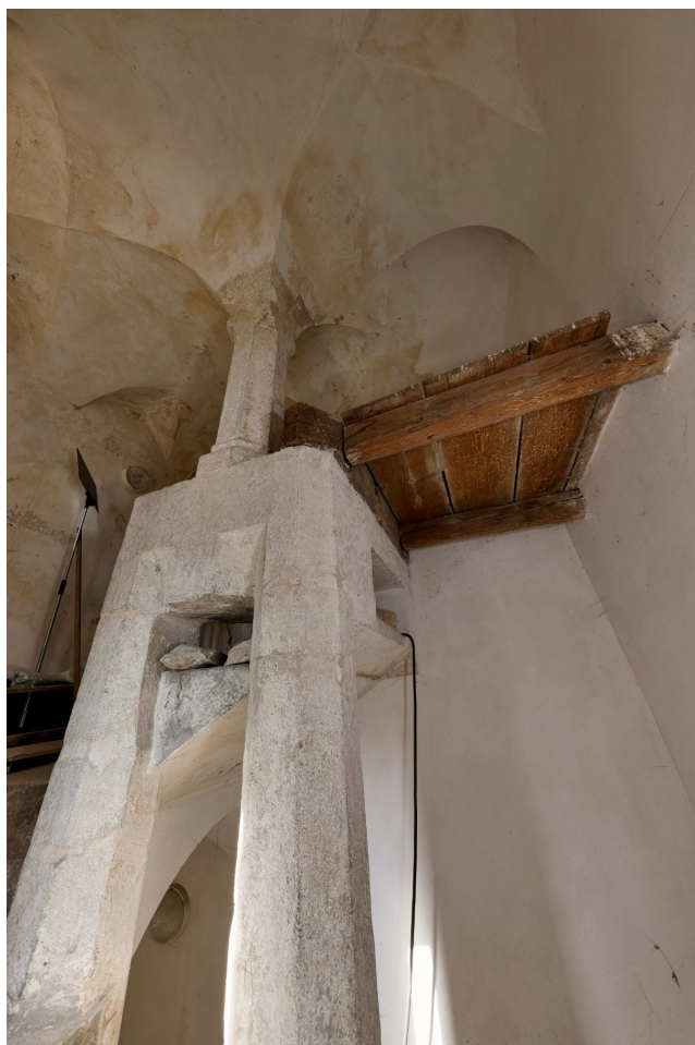
40. Kamenná dvojice pilířů pod centrálním pilířem a klenbou uprostřed schodišťového prostoru u SZ kamenného čtyřramenného schodiště.
