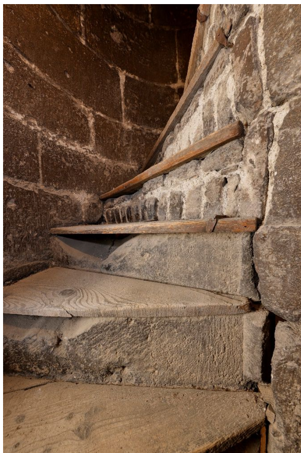
8. Nejvyšší partie JZ kamenného točitého schodiště podezděné cihlami.
