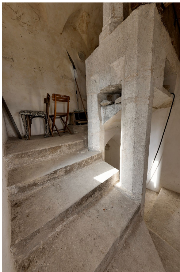
41. Kamenná dvojice pilířů pod centrálním pilířem a klenbou uprostřed schodišťového prostoru u SZ kamenného čtyřramenného schodiště.
