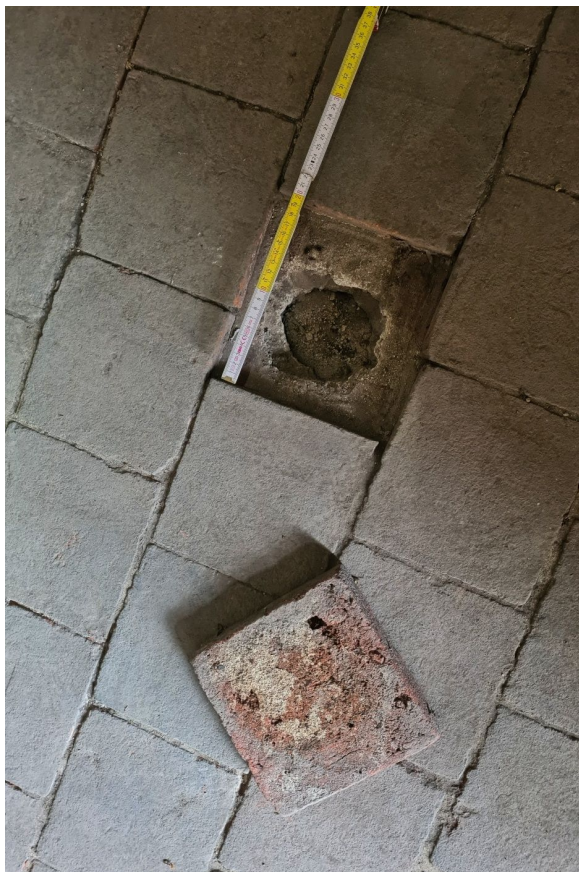
36. Detail skladby podlahy pod dlažbou z keramických půdovek (topínek) v síni ve 3. NP ve věži.
