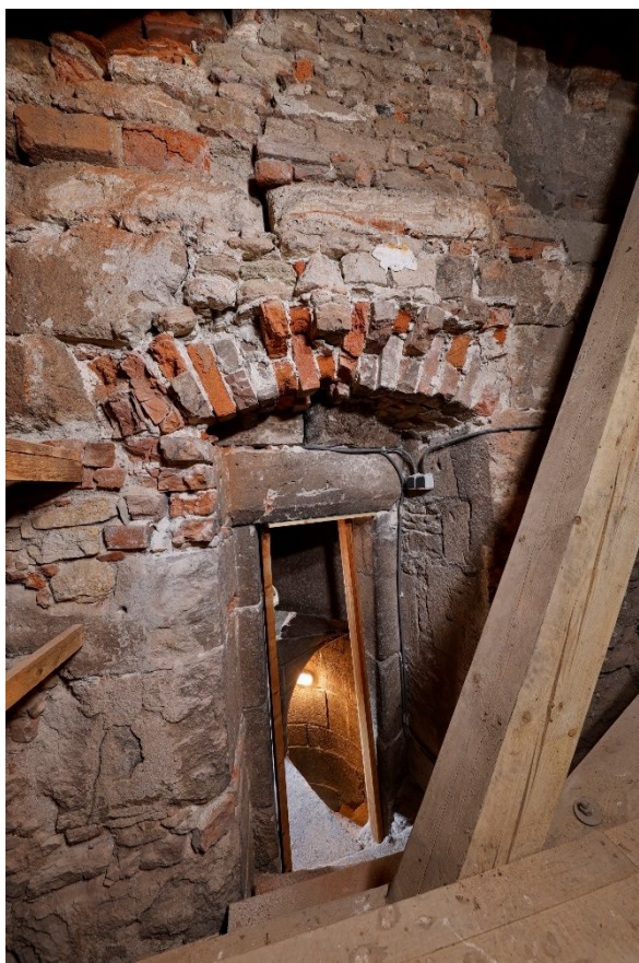
16. Celkový pohled z půdy na statickou poruchu v nadpraží vstupního otvoru z JZ kamenného točitého schodiště na půdu.
