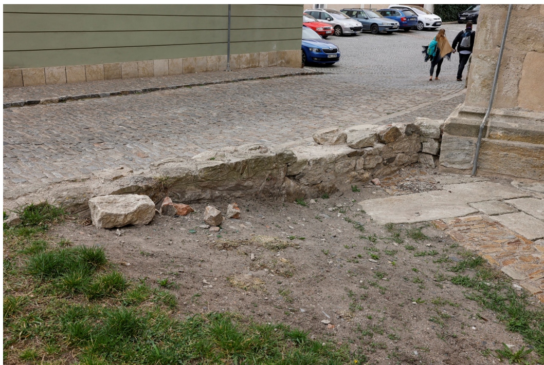
54. Detailní pohled na silně poškozené ukončení ubourané ohradní zdi na JZ straně bývalého hřbitova u kostela v místě se sníženým terénem.
