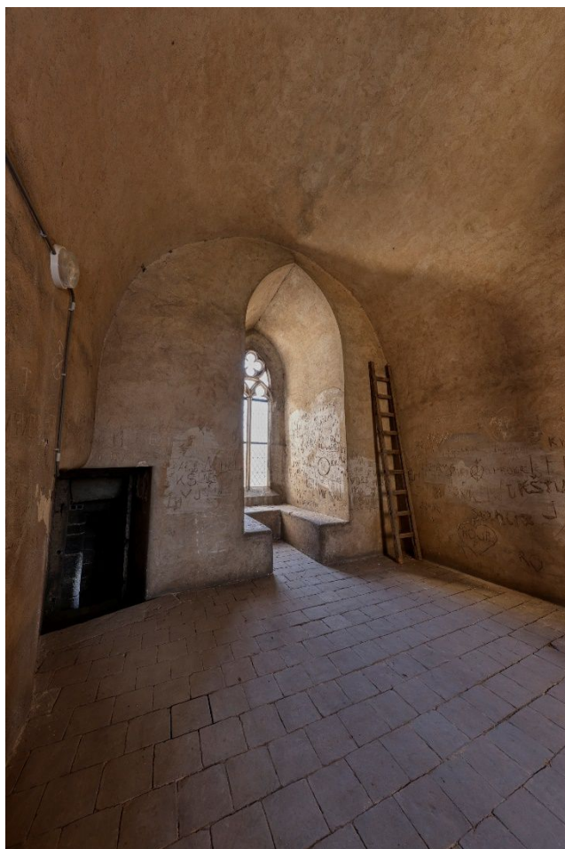
25. Celkový pohled na podlahu z keramických půdovek a na jižní stěnu s oknem a vstupem do pokladnice ve 2. NP ve věži.
