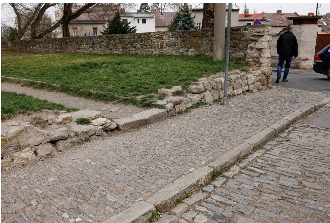
45. Pohled na východní část ubourané ohradní zdi na JZ straně bývalého hřbitova s uvolněnými kameny a vyplaveným spárováním.
