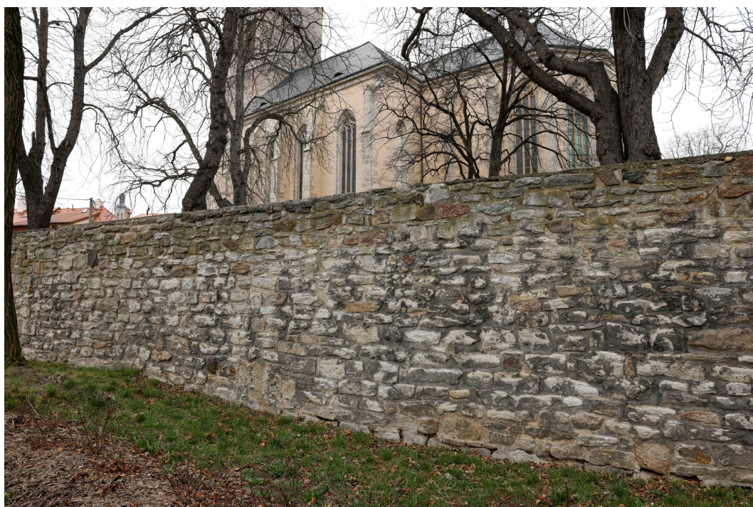
48. Detailní pohled na spárovaný líc režného zdiva z lomových kamenů u JZ části ohradní zdi.
