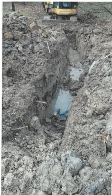
15, 16, 17/ Stoka A Š90-Š93 rozsah opravy drenáží novým provedením od místa ucpání
