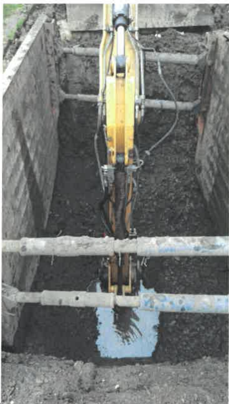
9/ Provádění Š78 stoka A, patrné skalní prostředí 10/ Jáma při vrtání u Š56 se skladbou skalního prostředí
