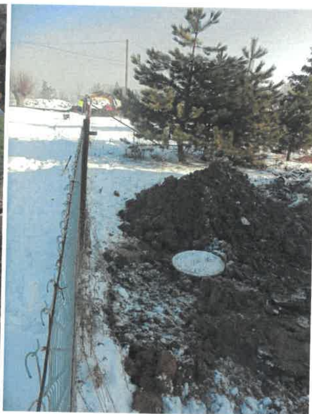
19/ provedení ukončující šachtice P35
