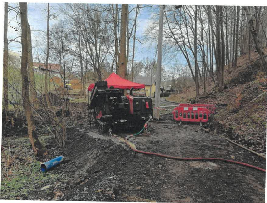
12/ Mikrotunelování stoka A-12 u Š56
