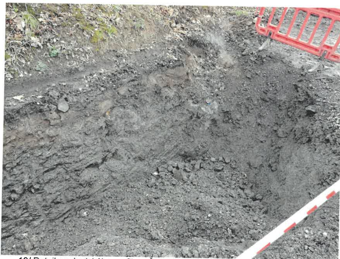
13/ Detail geologického profilu u Š56 v místě napojení stoky A-12 na stoku A
