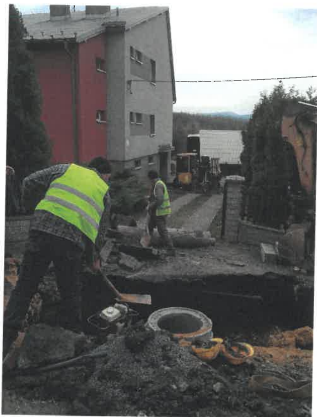
1/ Stoka A-19 v napojení na sotku A Š102
