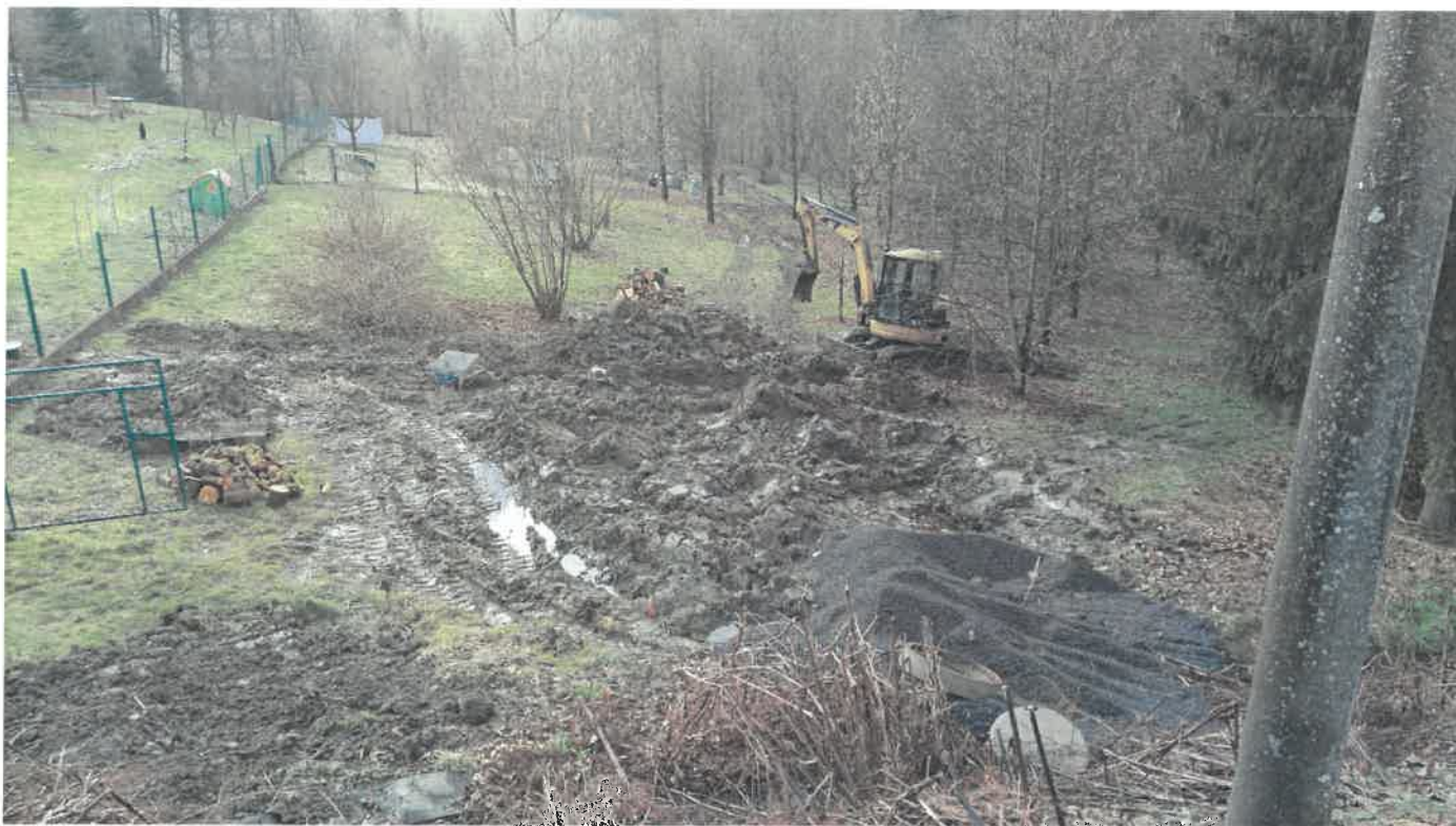
14/ Stoka A oblast Š90-93 provádění opravy drenáží novým provedením
