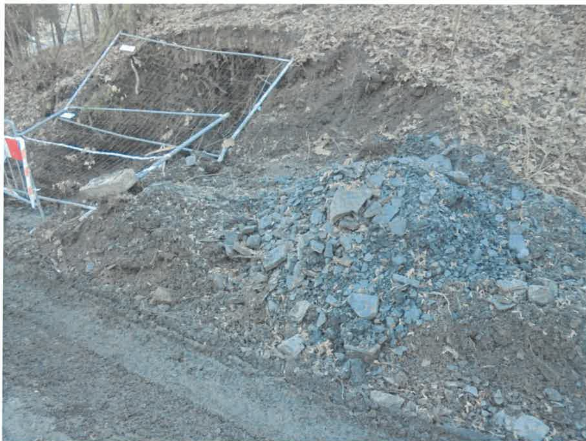
5/ Výkop při vrtání u Š77
