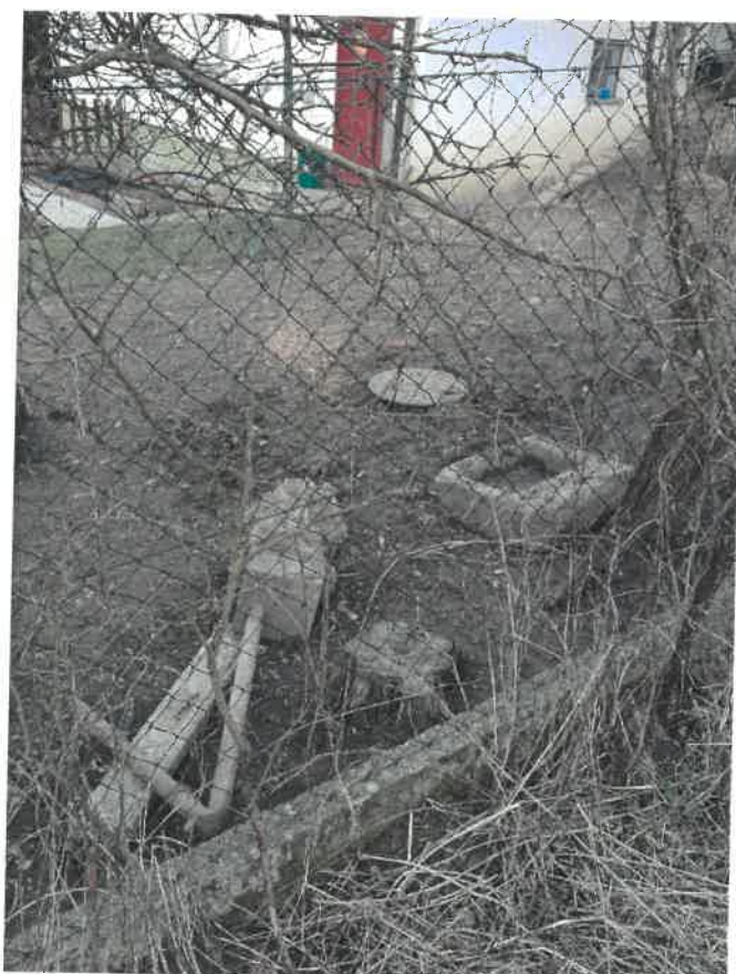
20/ Přípojka P109 ukončení u objektu pí Valachová
