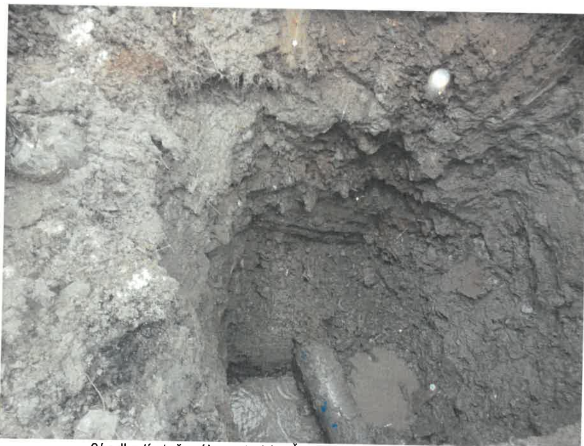
8/ odkrytí vtaženého potrubí u Š77 před prováděním šachtice
