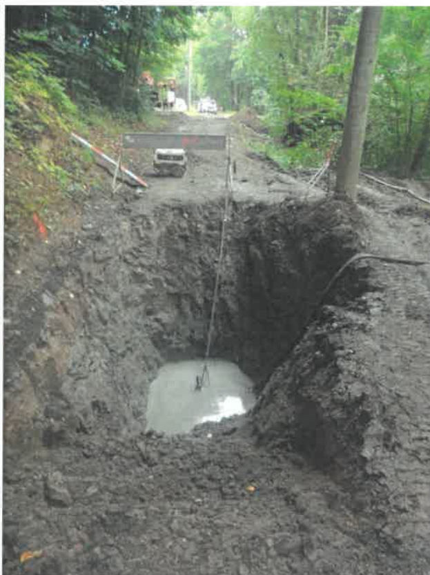
9/ Provádění Š78 stoka A, patrné skalní prostředí 10/ Jáma při vrtání u Š56 se skladbou skalního prostředí
