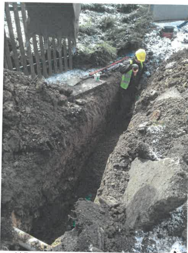
2/ Provádění přípojky P32
