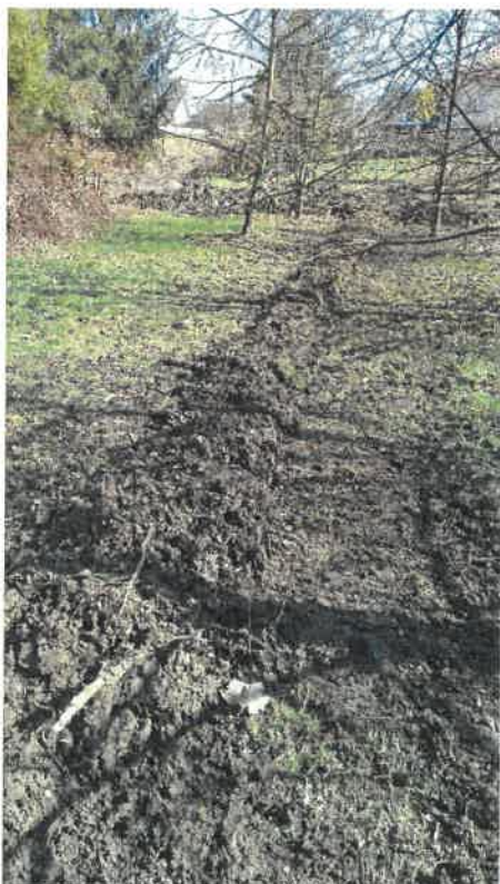
15, 16, 17/ Stoka A Š90-Š93 rozsah opravy drenáží novým provedením od místa ucpání
