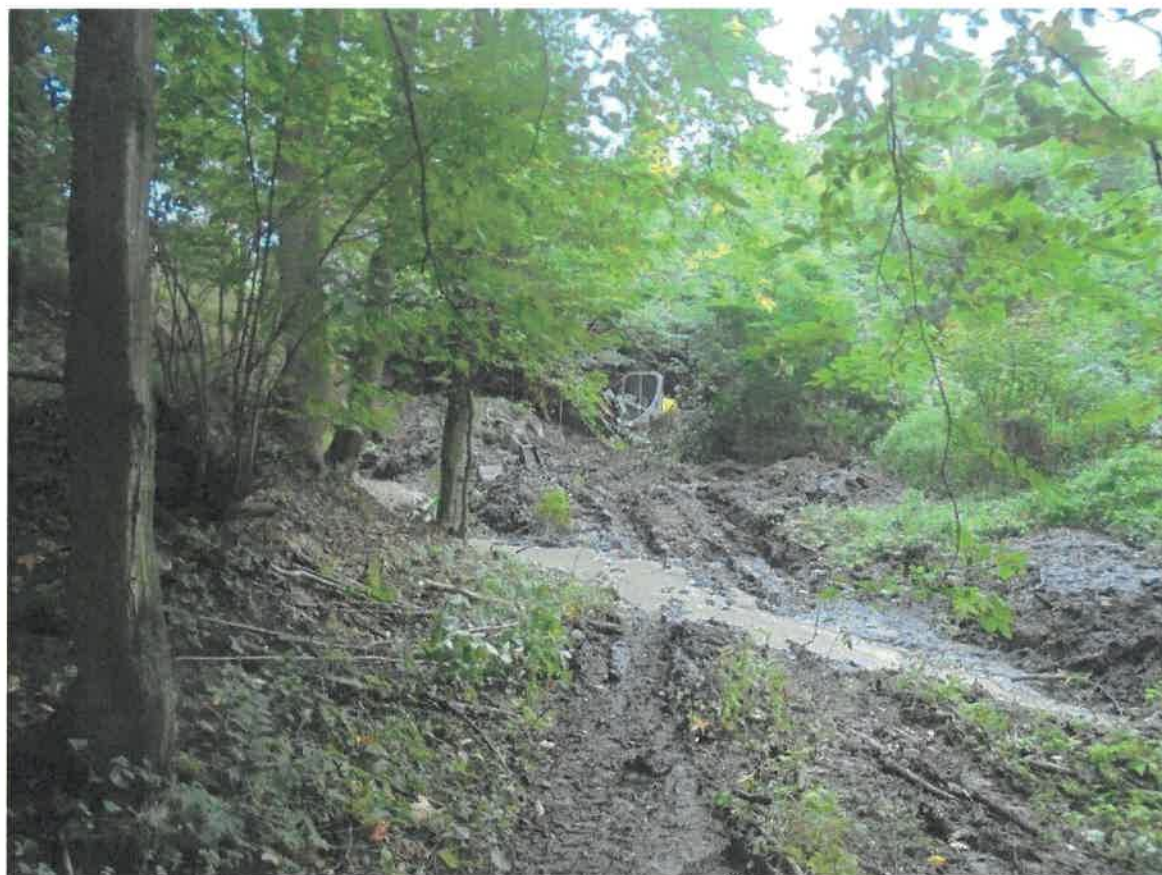
12/ Provádění oblast p. Mucha Š43 – Š53
