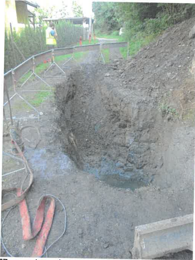
5/ Výkop pro vtažení u Š57 se zachycením skalního podloží – pohled k budoucí Š58 u RD č. p. 2192
