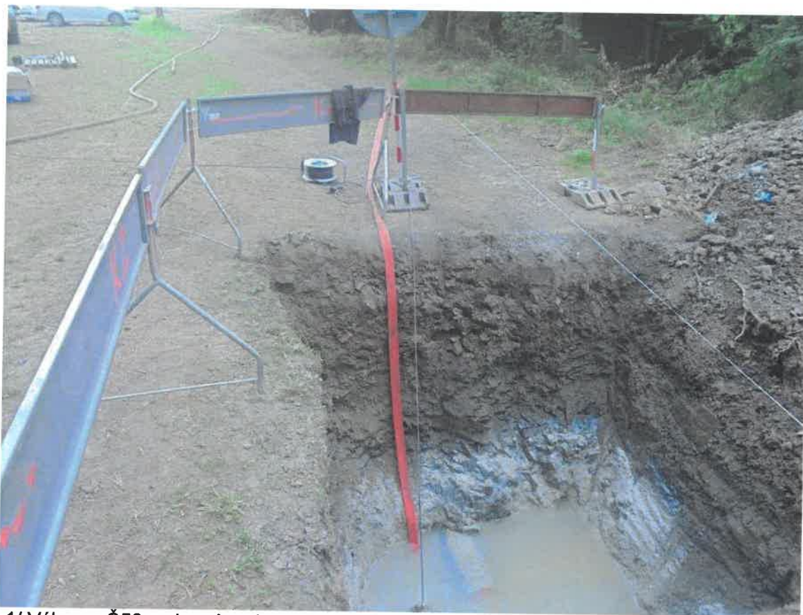
1/ Výkop u Š53a s jasným skalním prostředím v místě vyvrtaného kanalizačního potrubí
