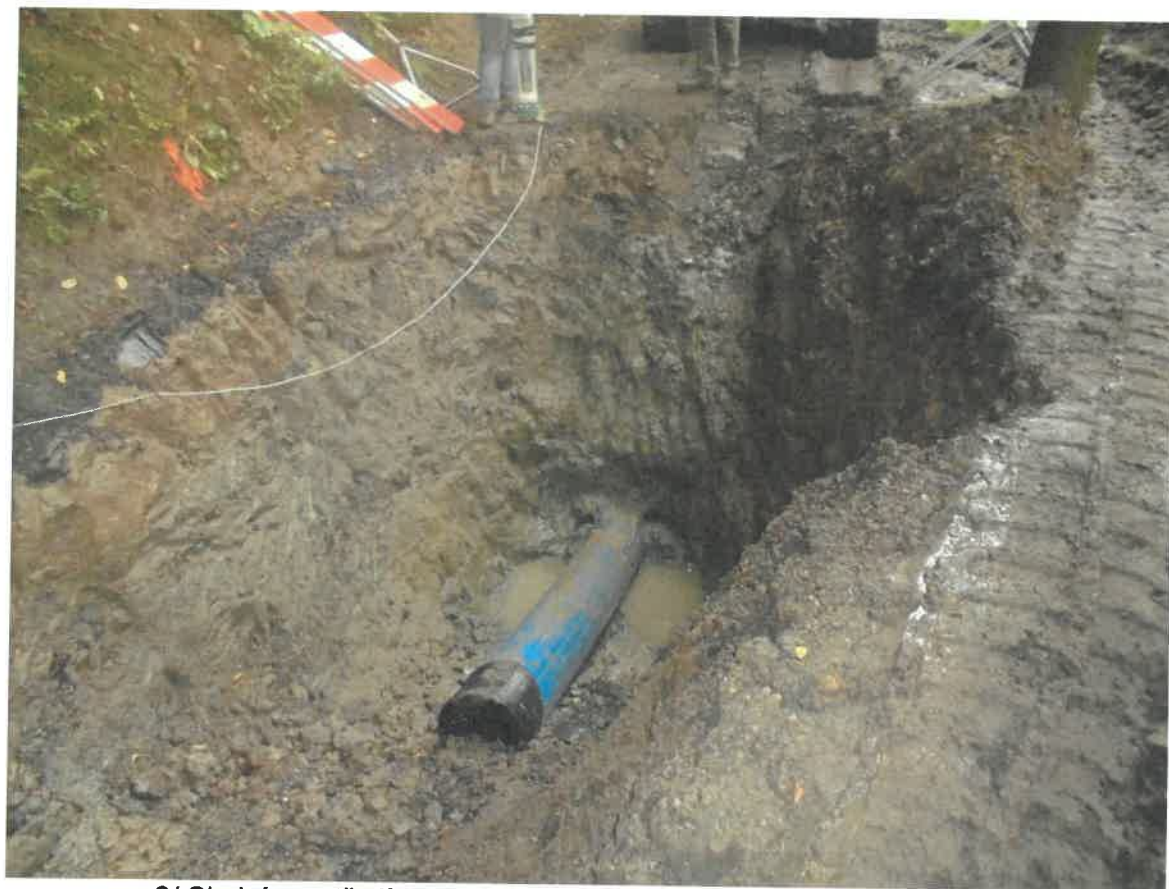
2/ Skalní prostředí s vtaženým potrubím po mikrotunelování u Š55
