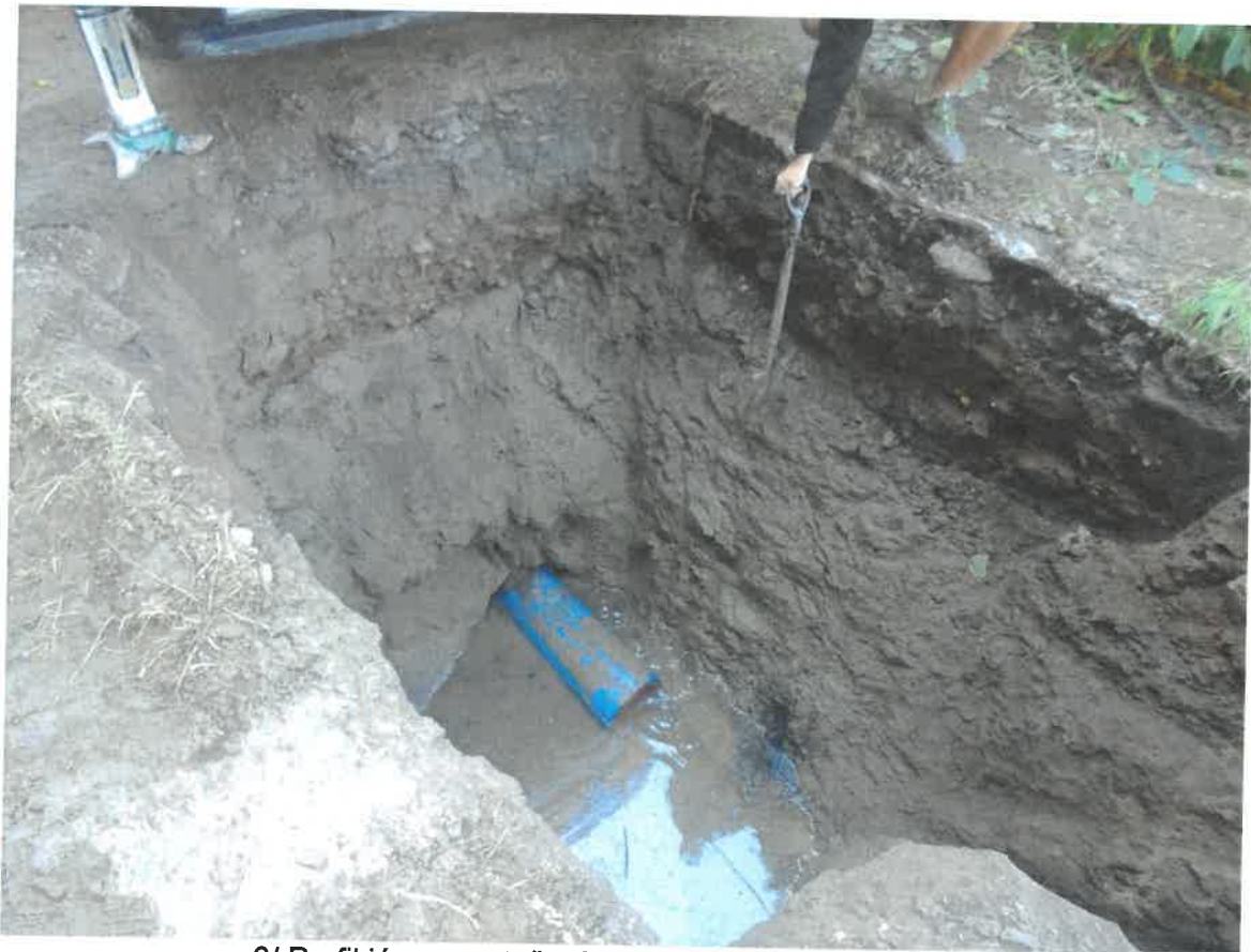
6/ Profil jámy po vtažení kanalizačního potrubí u Š58
