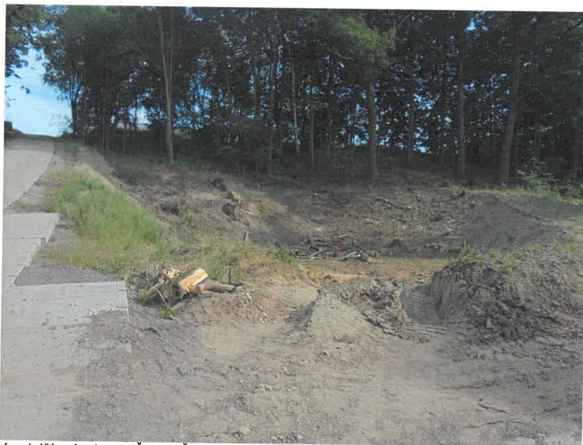
6/ Kácení v dalším úseku od Š12 k Š14 vč. nájezdů k původně umístěným šachtám, kde se prováděl IGP
