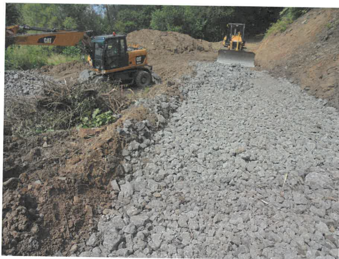
4/ Výměna neúnosného podloží mezi Š7-Š10
