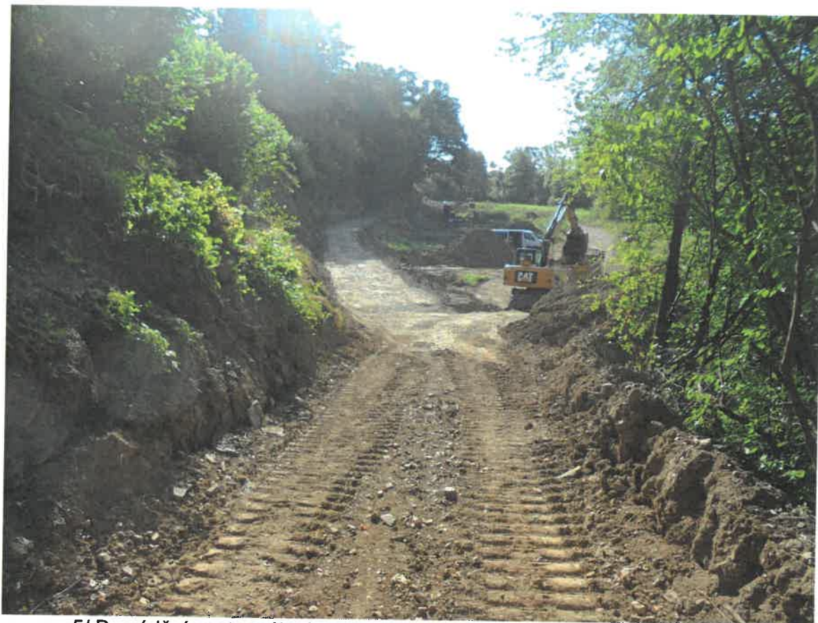
5/ Provádění postupného hutnění násypu kanalizace, pohled od Š6 k Š12
