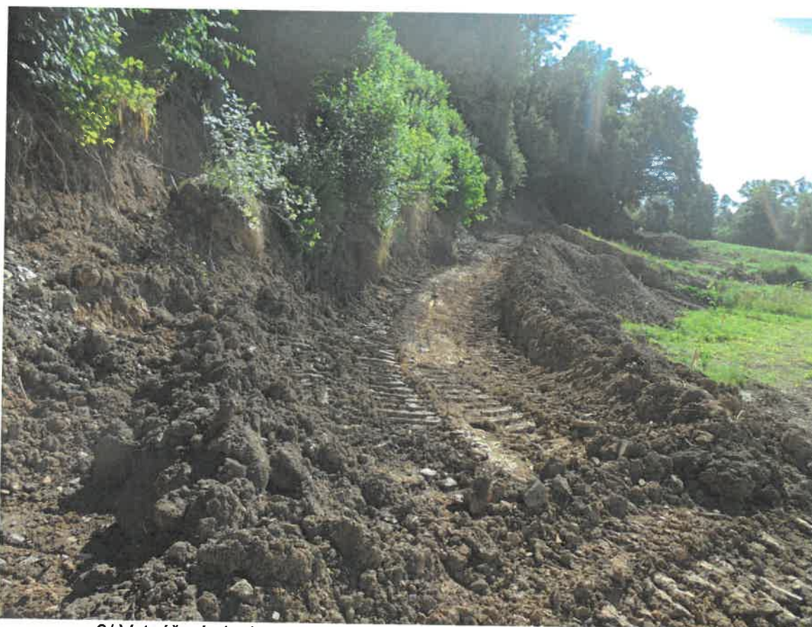
3/ Vytváření plochy pro budoucí násyp kanalizace v místě Š7 – Š10
