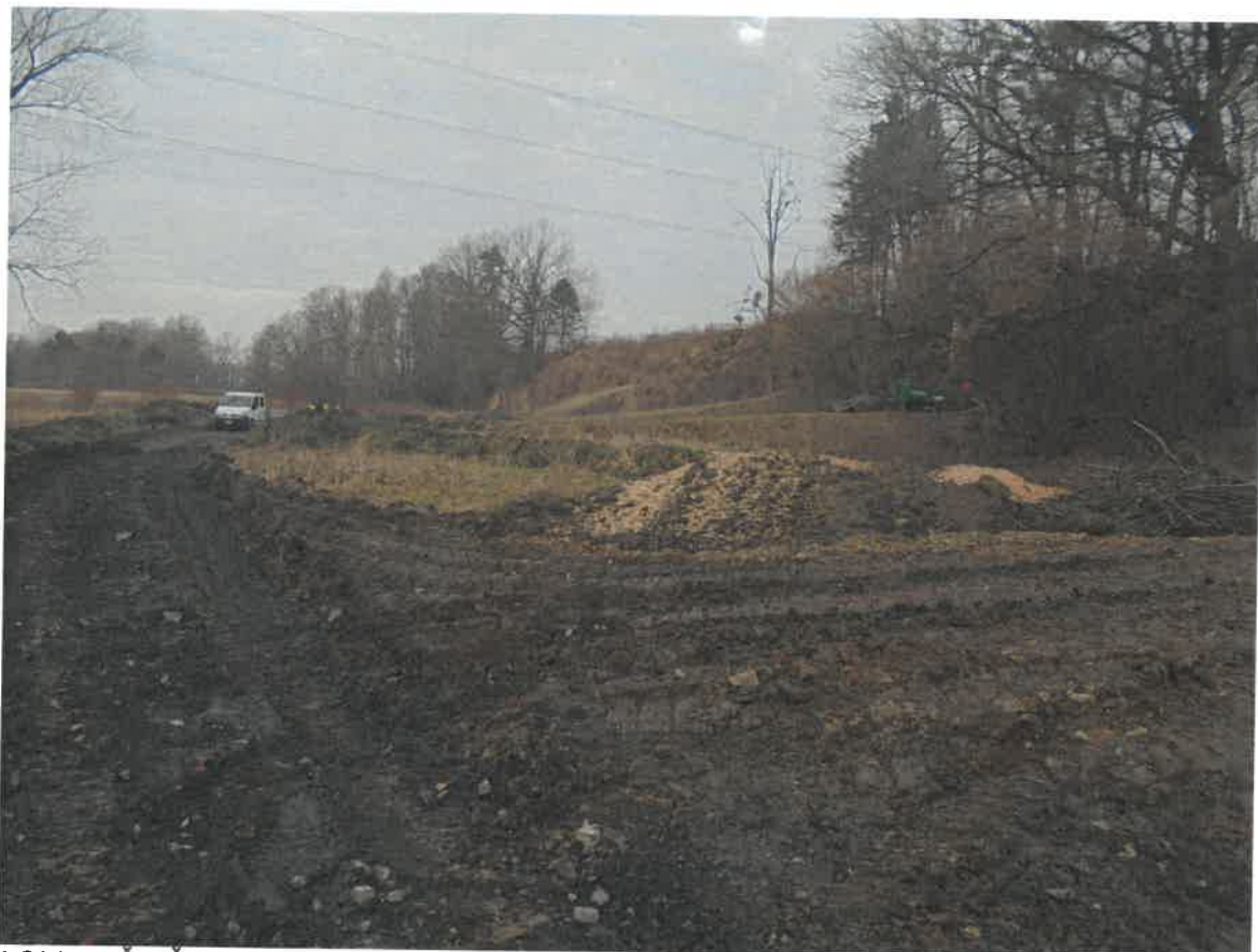
1/ Oblast Š6-Š12 provedeny rampy pro budoucí umístění kanalizace dle PD, provádění IGP
