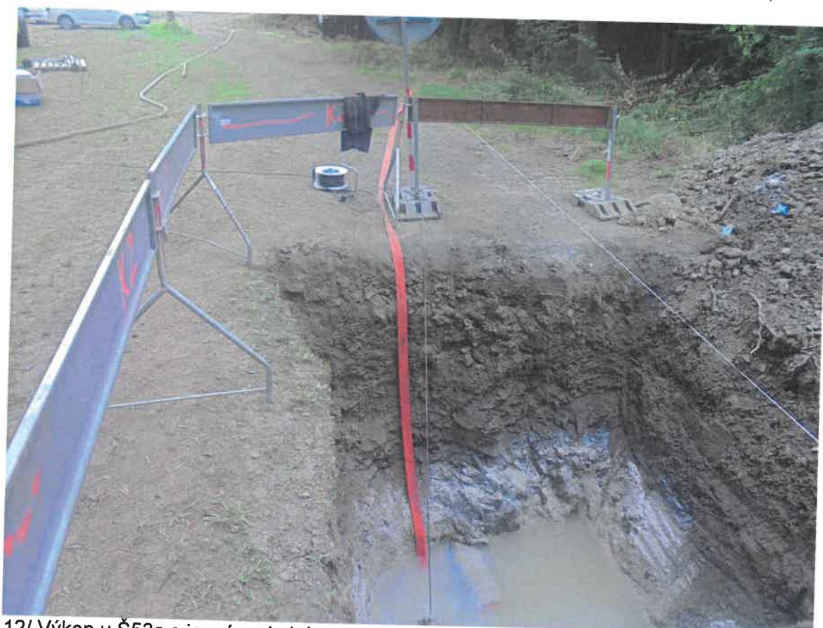
12/ Výkop u Š53a s jasným skalním prostředím v místě vyvrtaného kanalizačního potrubí
