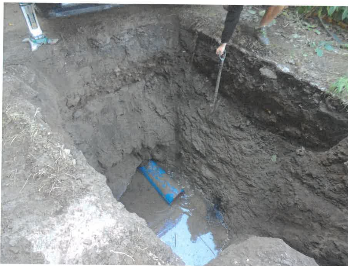
16/ Profil jámy po vtažení kanalizačního potrubí
