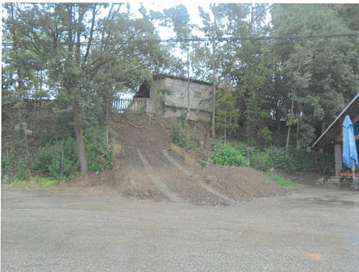
7/ Vykácené stromy, posun umístění šachty mimo HB, vybudování nájezdu pro „hřebíkování“
