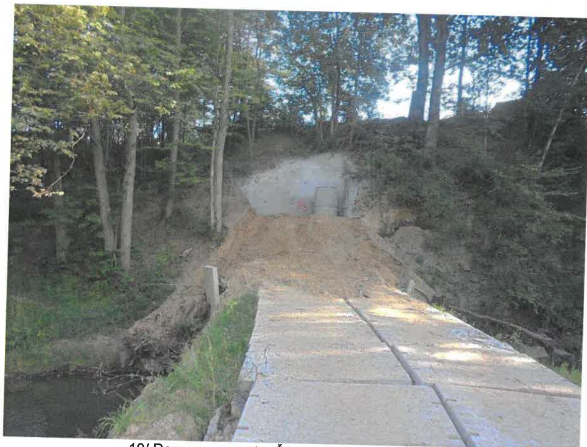
10/ Rozpracovanost u Š5 s osazenou částí šachty
