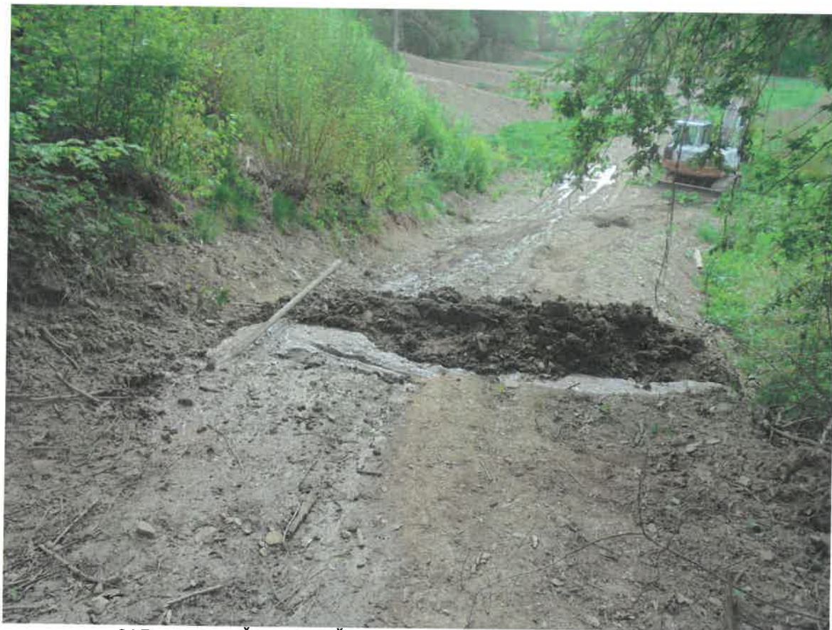
2/ Pohled od Š6 dále k Š16 se zachycením jádrového vrtu od Š5
