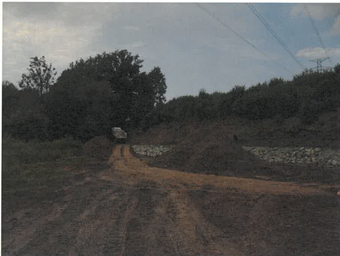
8/ Provádění násypu pro kanalizaci a zpevnění (přitížení) paty svahu lomovým kamenem
