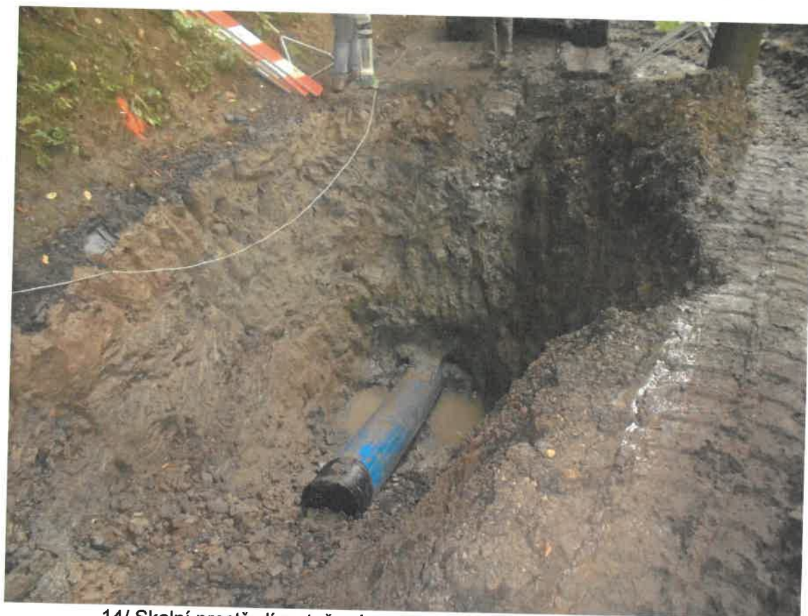
14/ Skalní prostředí s vtaženým potrubím po mikrotunelování u Š55
