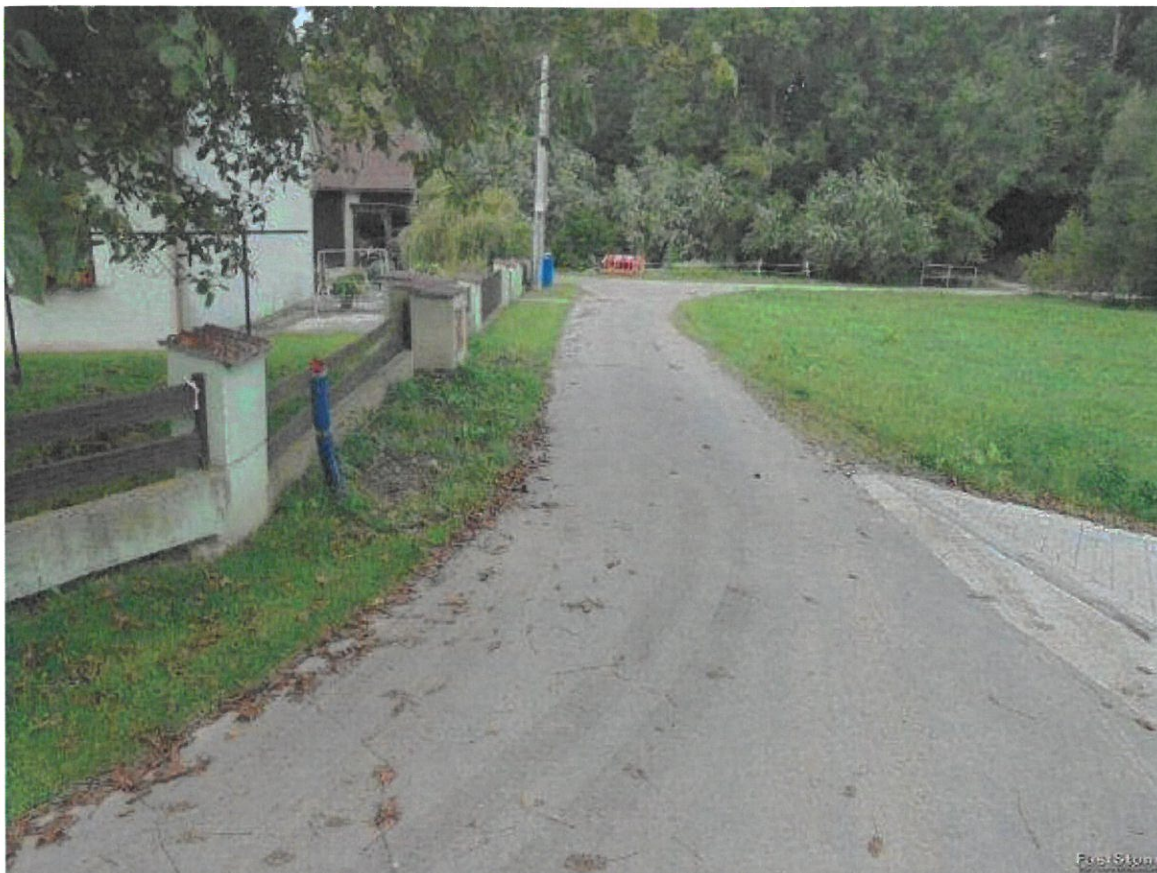
1/ Pohled oblast vodovodu ul. z kopce u RD č. p. 24/4 p. Godula
