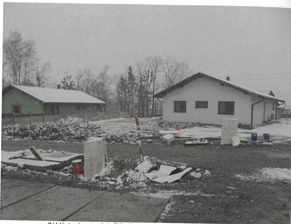
3/ Výstavba nových RD (Stoka A-17) č. p. 1007/10 a 1006/8
