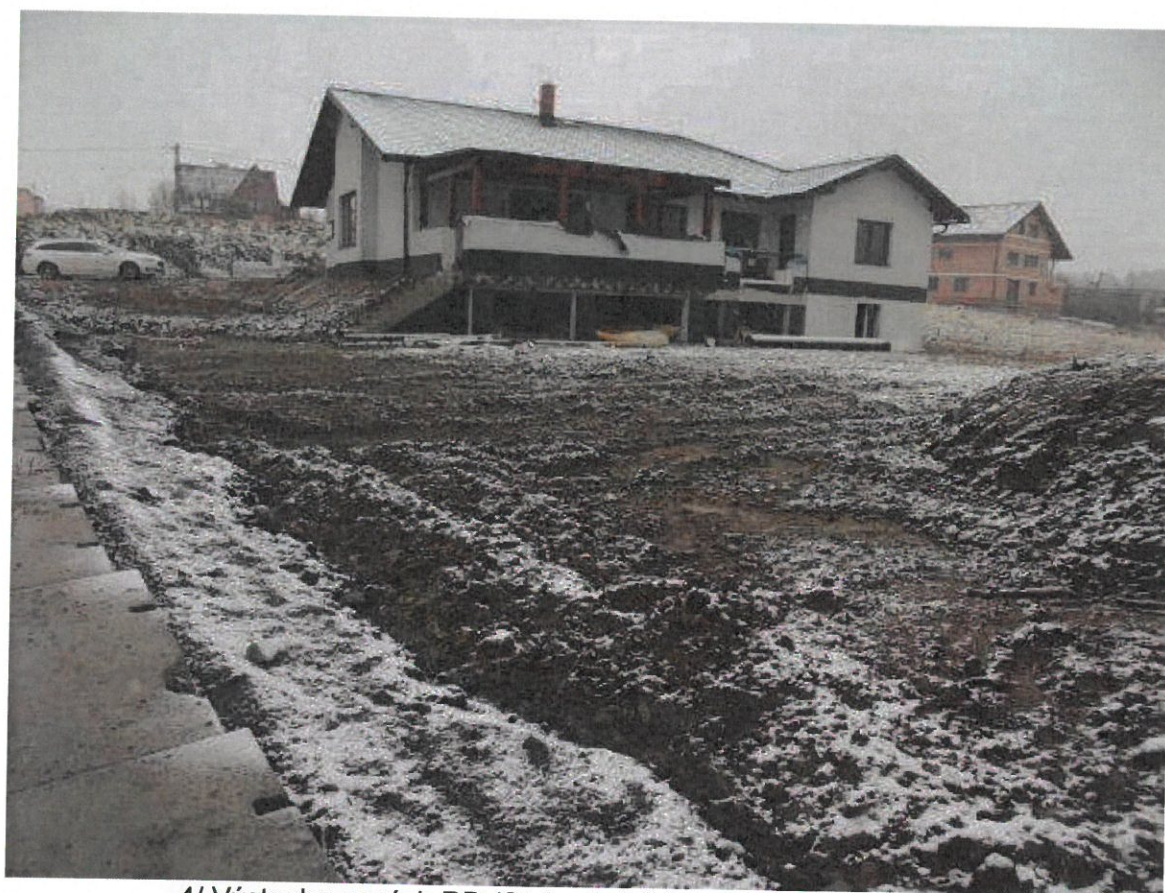
4/ Výstavba nových RD (Stoka A-17) č. p. 1008/12 p. Plaskura
