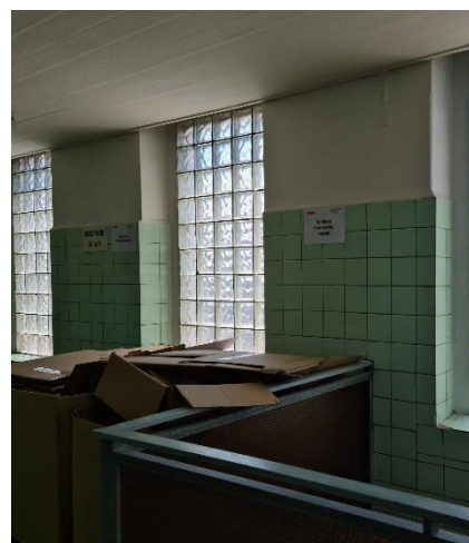
Obr. výrobní budova – okno 1,17 x 1,75 luxfer
