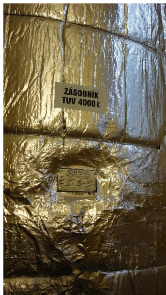
Obr. Výměník TV a akumulční nádoba
