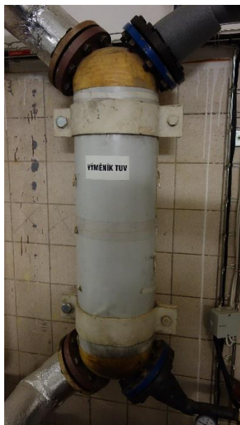
Obr. Výměník TV a akumulční nádoba
