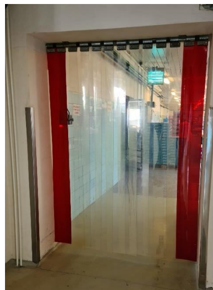
Obr. vnitřní prostory rozdíl teplot – instalace dveří
