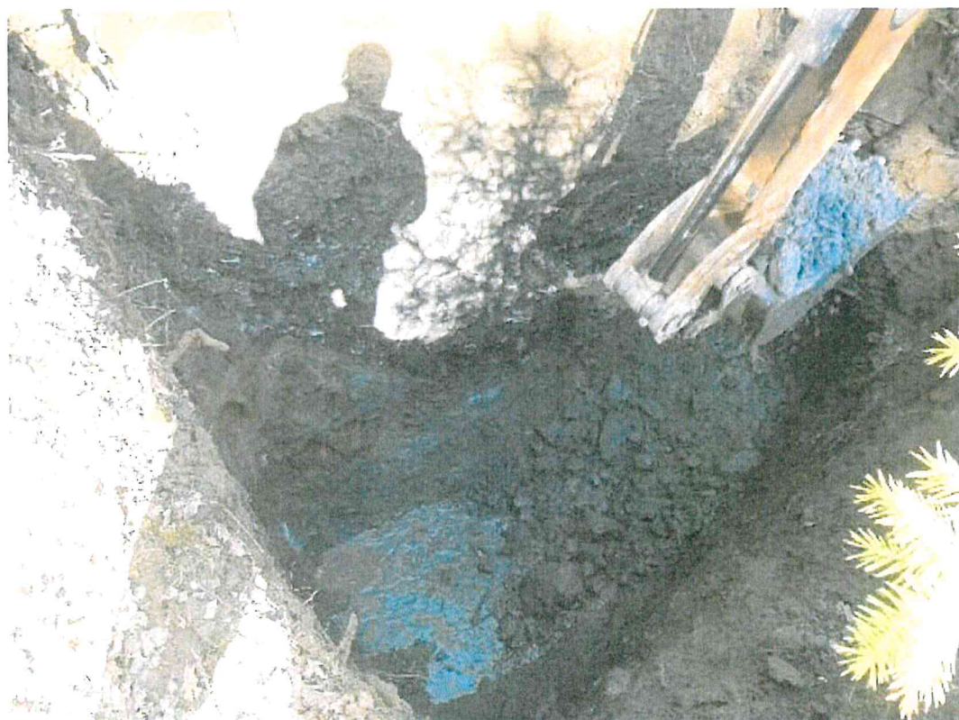
9/ Zachycení průběhu výběru skalního prostředí po jeho rozbití v místě budoucí Š42 – součástí výpichu HDD
