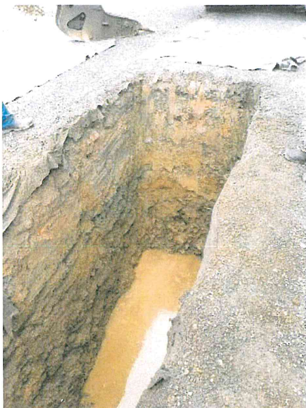
7/ Výkop pomocné jámy pro rozbití skalního prostředí pro možnost pokračování ve vrtání, v komunikaci před Š40
