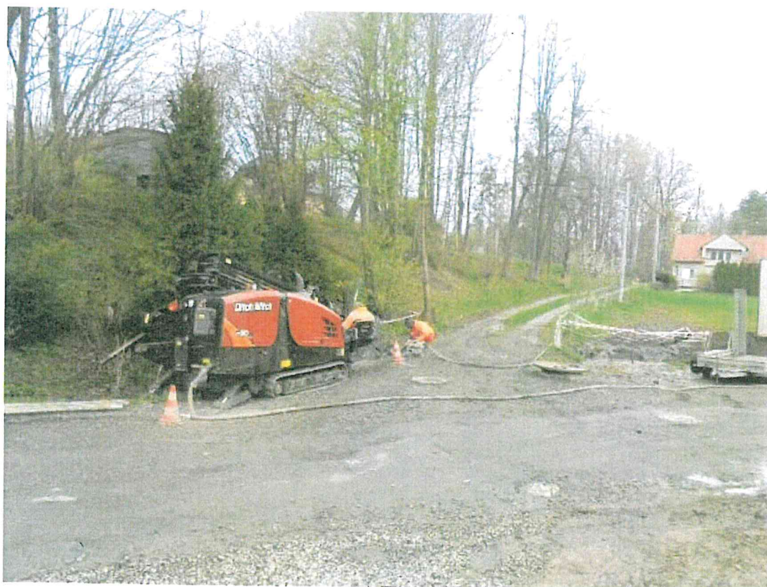
4/ Pohled při mikrotunelování
